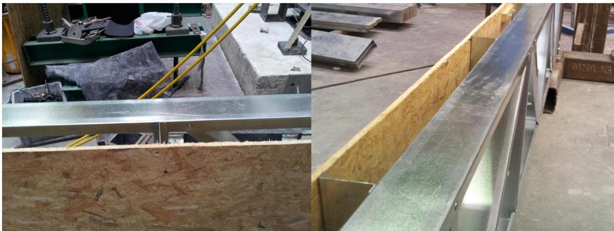
Figura 3.13 – Pormenor da fixação das placas de OSB à estrutura
