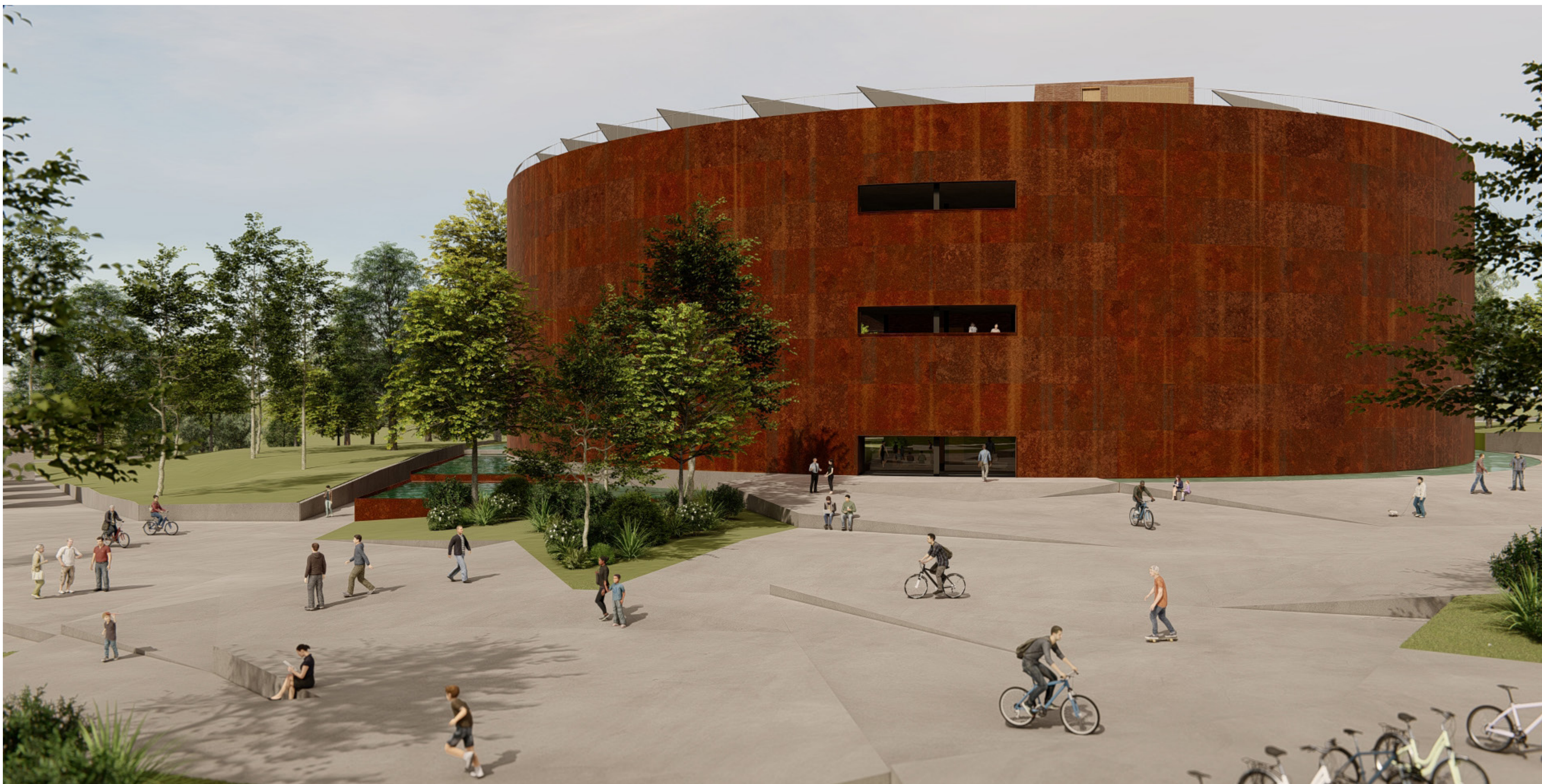
Fachada Principal da Habitação Comunitária (co-living) - Silo A
