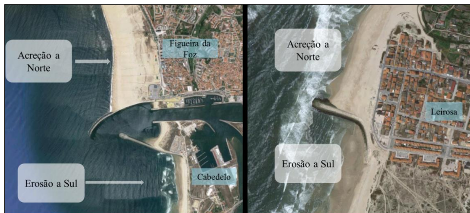
Figura 5 – Exemplos dos efeitos da interrupção do trânsito sedimentar por parte de estruturas marítimas longitudinais. À esquerda o molhe Norte do Porto da Figueira da Foz e à direita, um esporão na Leirosa (localidade a sul da Figueira da Foz). A diferentes escalas as consequências são semelhantes, ocorre uma excessiva acumulação de sedimentos a Norte enquanto as localidades a Sul sofrem de déficit sedimentar, estando assim mais expostas aos fenómenos de galgamento e inundação.
