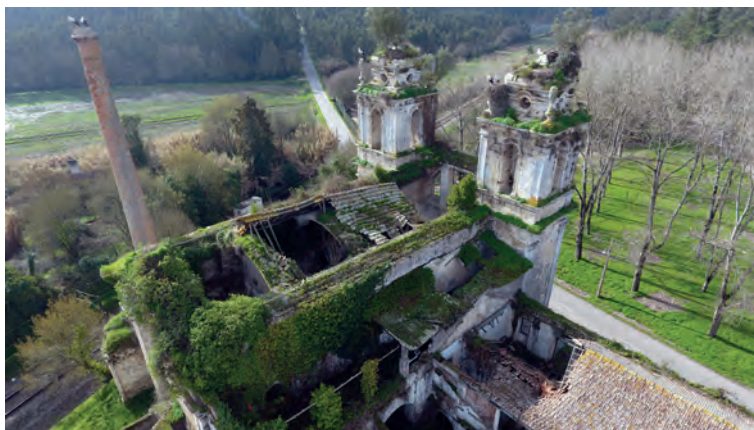
Figura 72 | Igreja de Santa Maria de Seiça em elevado estado de degradação, 2018
