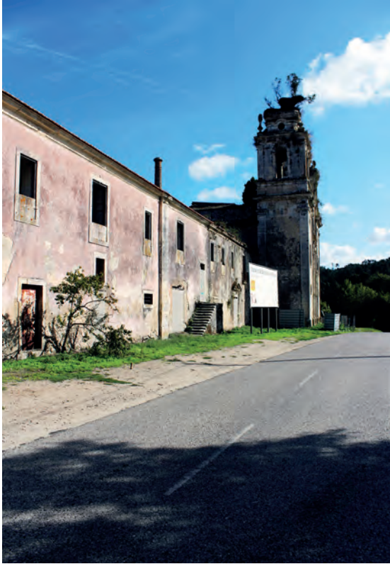
Figura 85 | Fachada principal. Fotografia do existente, 2020
