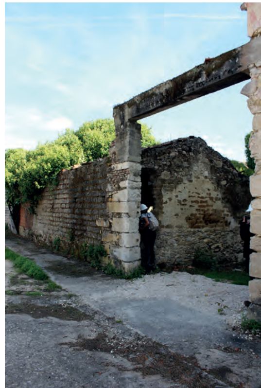
Figura 88 | Pátio Norte. Fotografia do existente, 2020
