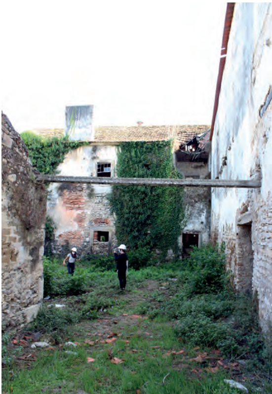
Figura 87 | Pátio Norte. Fotografia do existente, 2020
