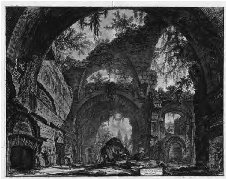
Figura 7 | "Rovine d'una Galleria di Statue nelle Villa Adriana a Tivoli", Giovanni Battista Piranesi
