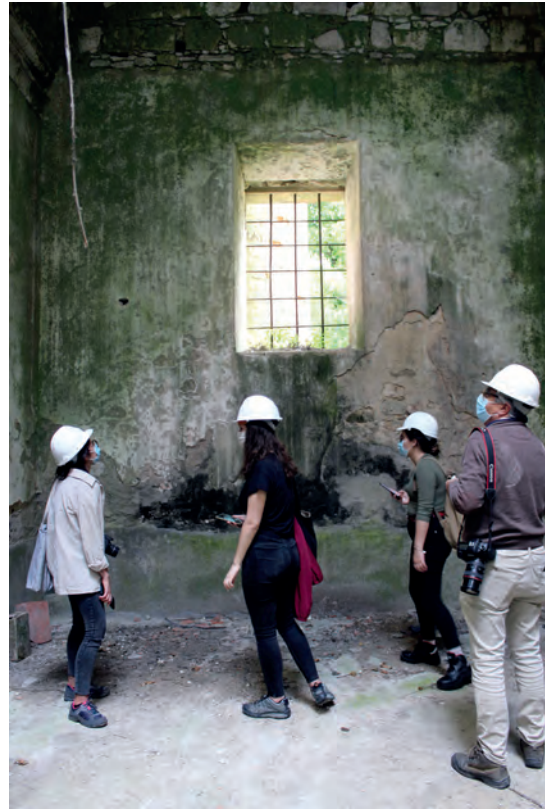
Figura 68 | Quarto tramo da nave principal. Fotografia do existente, 2020
