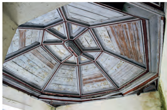
Figura 84 | Sala abacial. Fotografia do existente, 2020
