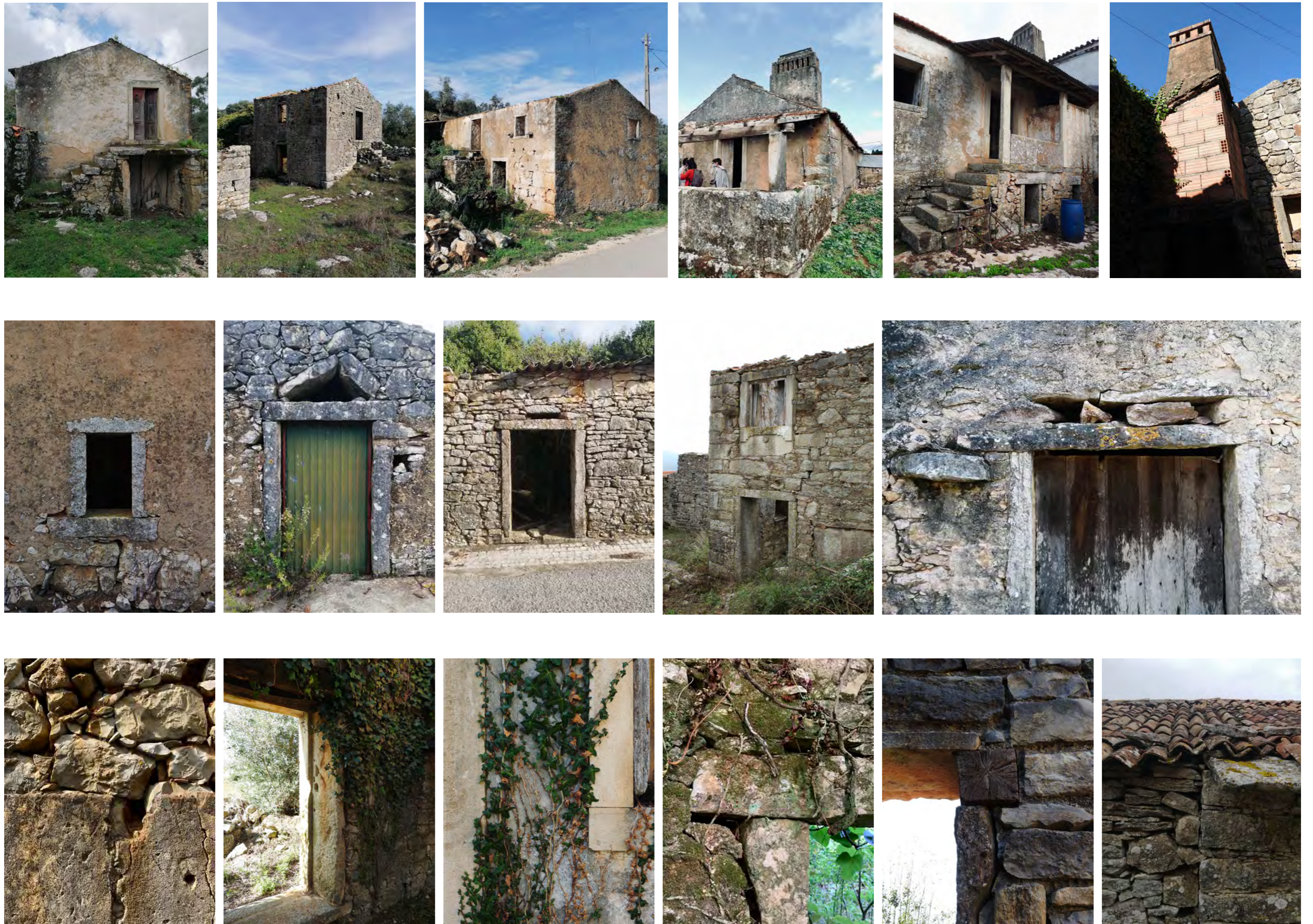
Fig. 34- Identificação de diversos momentos da arquitetura vernácula, nas habitações em Sicó (conjunto de imagens recolhidas nos campos de estudo nas aldeias da RAC)
