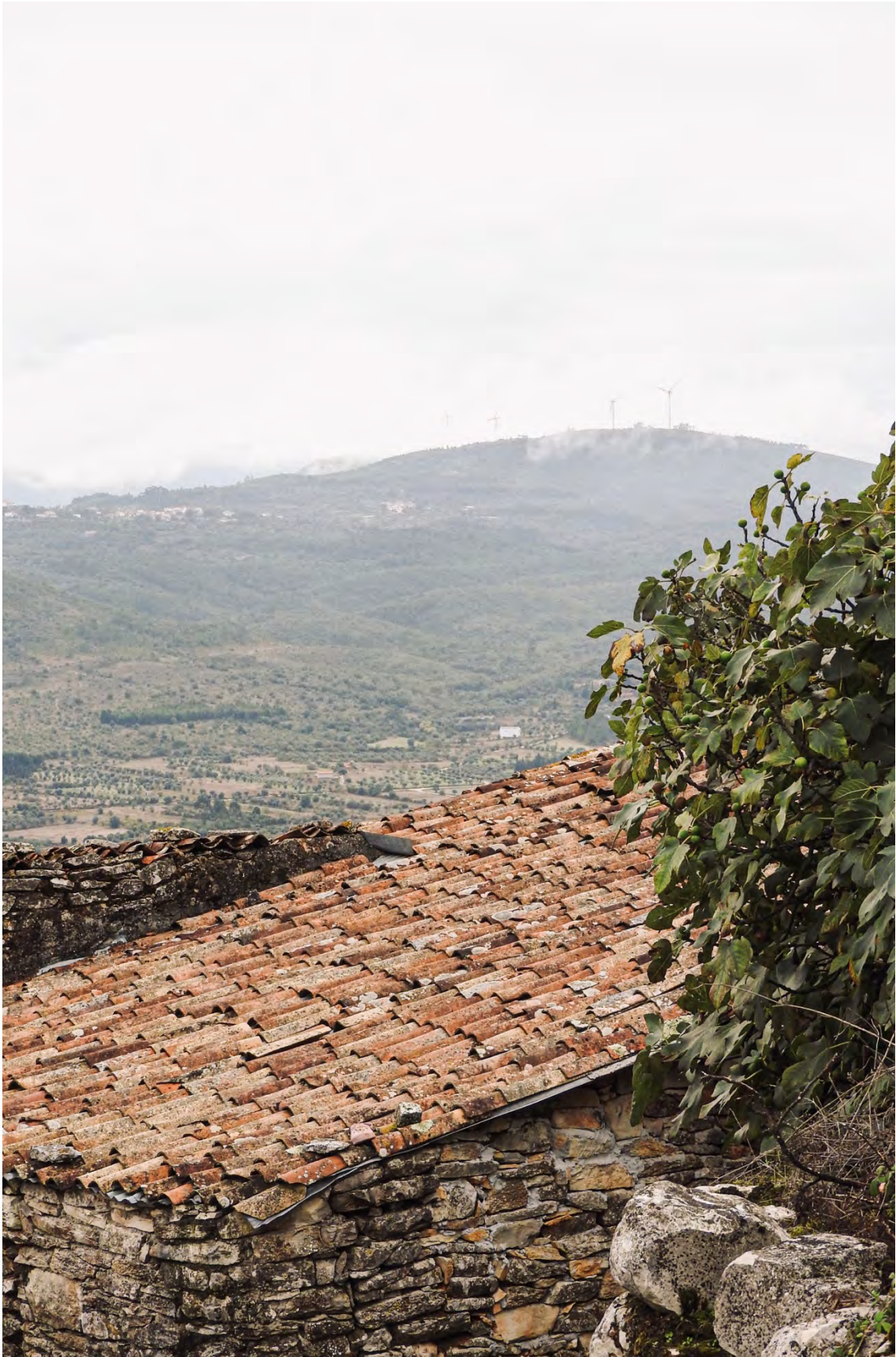
Fig. 27- Edifício na aldeia de Chanca. Setembro, 2020.
