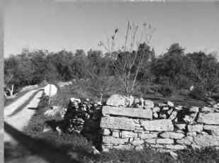
Figura 2 - Muros de Pedra Seca
