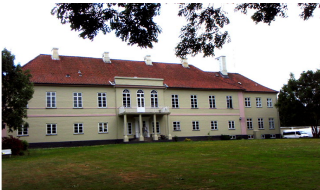
Figura 4. Mesma construção atualmente - resquício do mesmo patrimônio construído em 1830.
