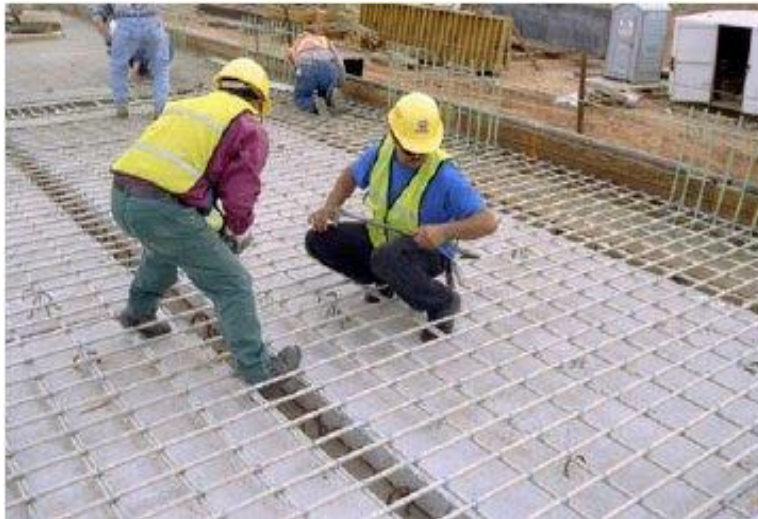
شکل ۲-۳: عرشه پل بتنی مسلح با میلگردهای FRP [۵]
