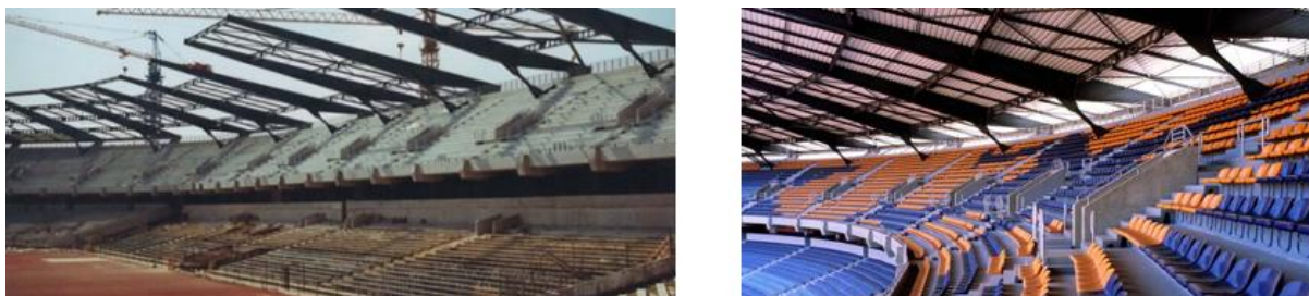
Figura 1.2 - Vigas de cobertura do Estádio Cidade de Coimbra, Coimbra, Portugal (TAL PROJECTO@, 2003).
