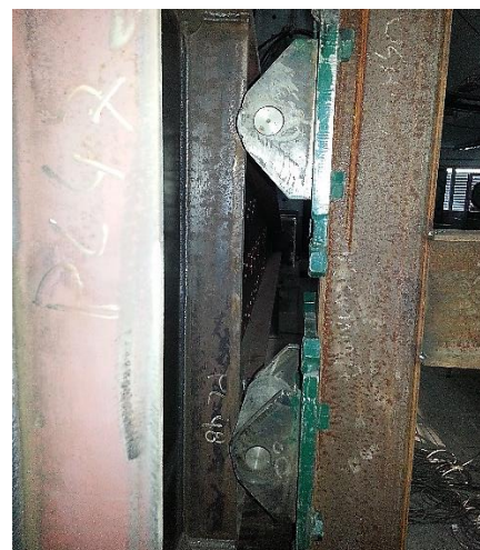
b) Travamento da Viga 2.
