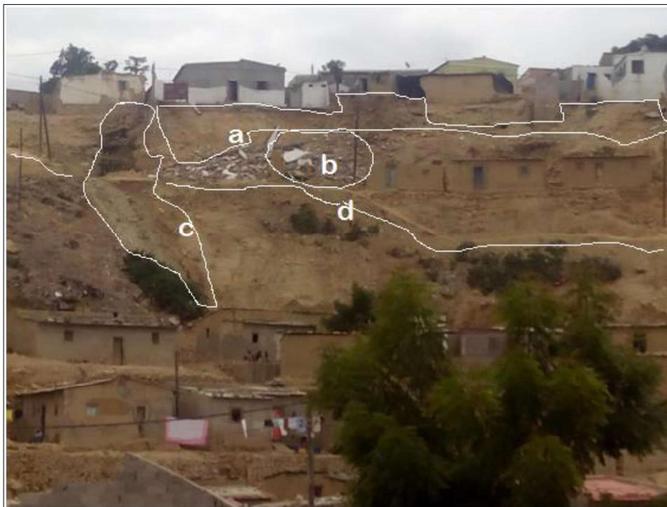
Figura 5.5: Ilustrações de movimentos: **a** - Desabamentos de muros de gravidades; **b**- Habitações atingidas; **d** - Obstruções das vias de acessos para outras habitações; **c** - Evidência de erosão.
