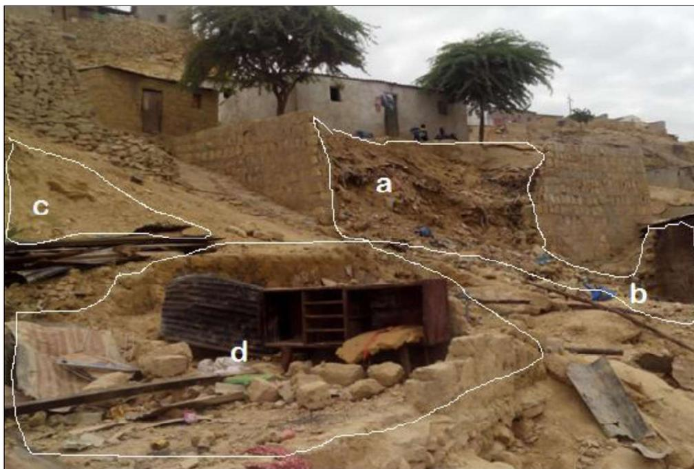
Figura 5.3: ilustrações de movimentos: **a** - Desabamento do muro; **b**- Atingimento da Habitação; **c** - movimento do material de aterro em consequência da presença da água; **d**- acumulação da água ao longo da habitação de adobes provoca desabamento e destruição de bens.
