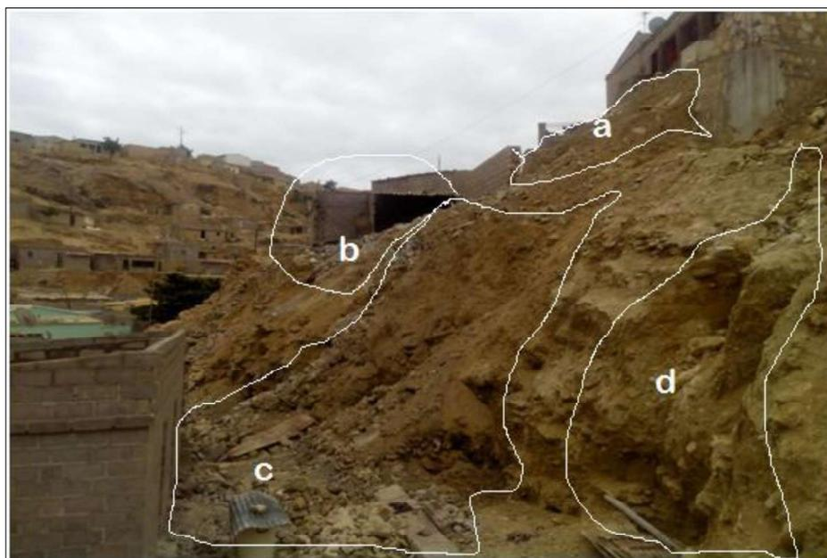
Figura 5.4 - ilustrações de movimentos: **a** - Desabamento de muro de gravidade; **b**- A Habitação atingida projeta-se para outra habitação; **c** - Evidências do material que caiu de cima para baixo, a reabilitação; **d**- evidências de erosão.
