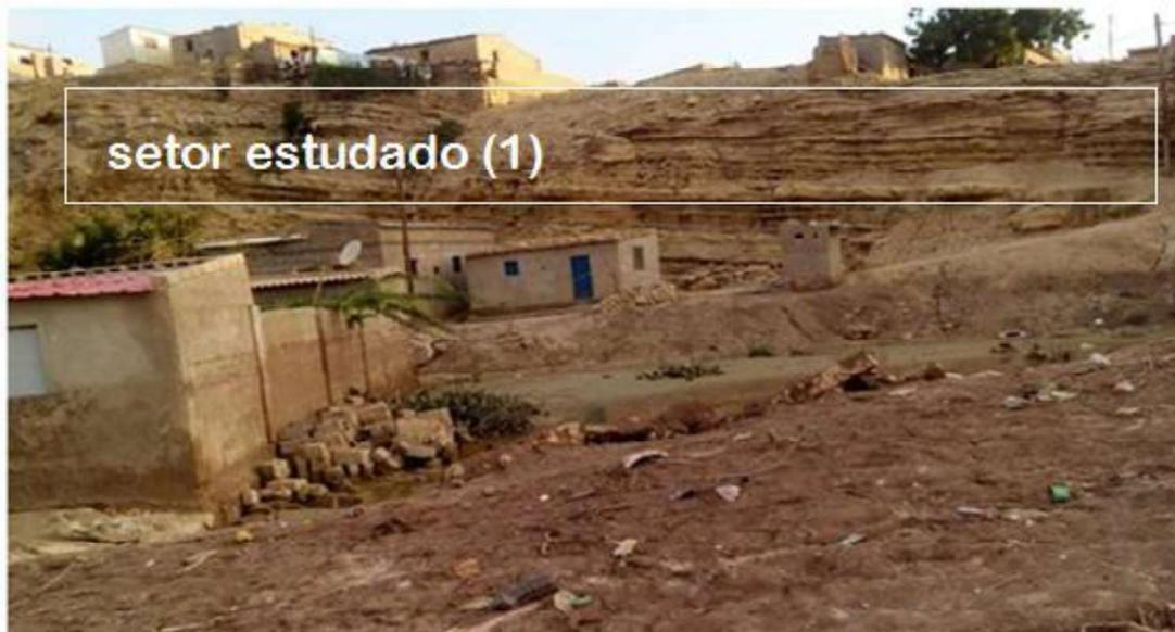
Figura 5.9 - Ilustração do setor 1 do talude C. Estratificação das camadas, vegetação, habitações e sinais de inundações provocadas pelas chuvas do dia 11 de março de 2015.
