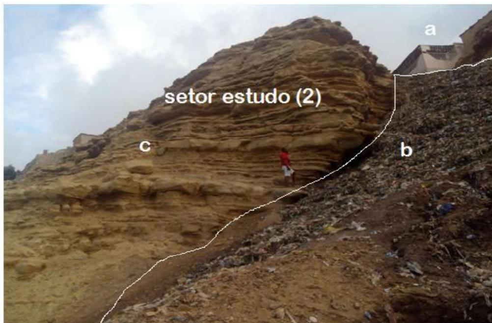
Figura 5.10: **a** - habitações no topo; **b** - visível grande quantidade de lixo na face do talude; **c** - ilustração da estratificação.
