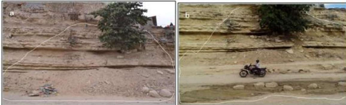
Figura 5.14 – **a** - Situações de instabilidades na época seca. Observa-se menores quedas de blocos e constrangimentos na circulação de pessoa e bens neste período; **b** - Situações de instabilidades na época chuvosa. Observa-se maior queda de blocos e constrangimentos na circulação de pessoas e bens neste período.
