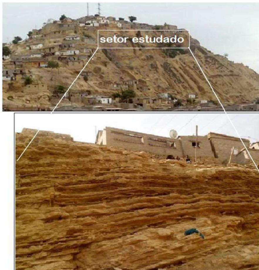
Figura:5.6 – A desagregação das margas ocasiona a perda de suporte das bancadas de calcário e a sua instabilização, conferindo aos maciços um comportamento muito evolutivo; calcários e Intercalações das camadas de margas com gesso; vegetação, lixo e habitações no topo e base do talude.
