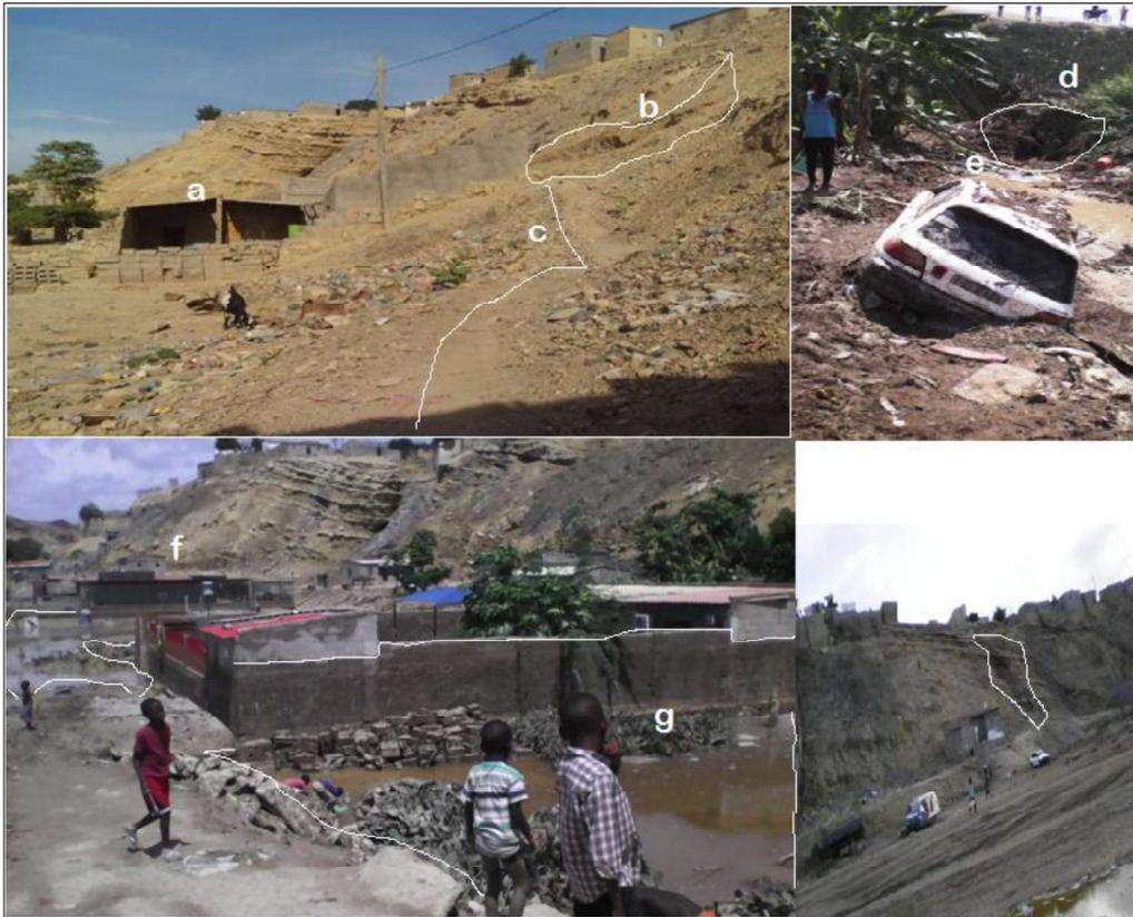
Figura 5.11 - **a** - Destruição da habitação; **b** - Obstrução da via de acesso para outras habitações; **e** - Movimentação do carro em cerca de 100 m, arrastado pelas águas provenientes das cotas mais altas; **d** - Obstrução do maior canal de escoação das águas; **f** - Bombas de combustível inundada, situada a menos de 30 m da base do talude; **g** - Evidências do nível das águas, ponto referência a residência que dista 20 m do setor estudado.
