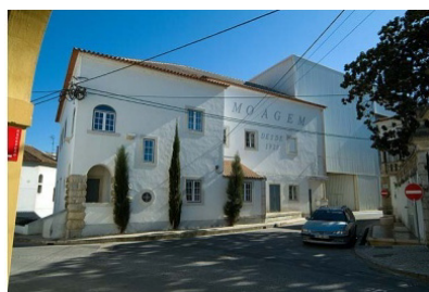
Fig. 78 | Edifício da moagem.
