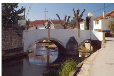
Fig. 75 | Ponte do Lugar Fontes.
