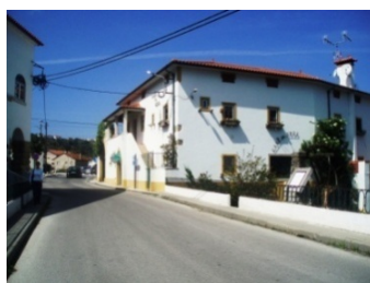
Fig. 76 | Vista da Ponte do Lugar Cortes.
