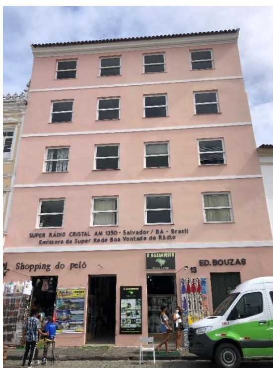
Figura 6.11 – Edifício 29. Acervo pessoal.
