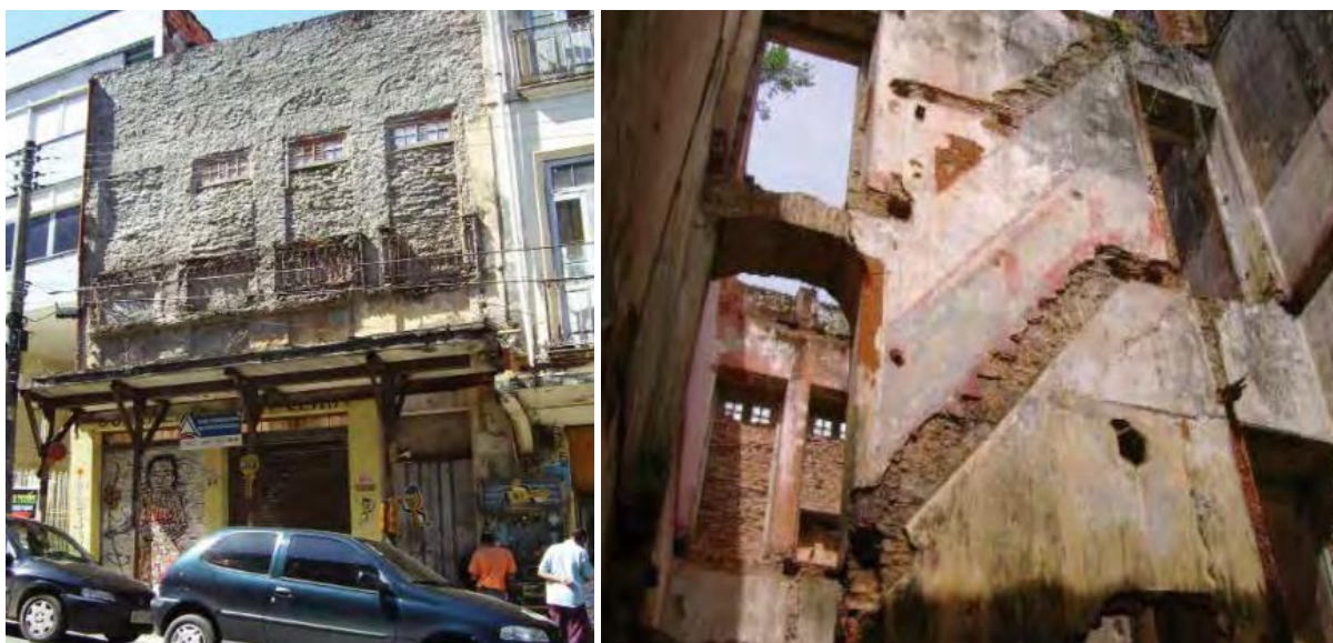
Figura 4.12 - Fachada e parte interna de imóvel na Ladeira da Praça. Arqueologia no Pelourinho (IPHAN, 2010)
