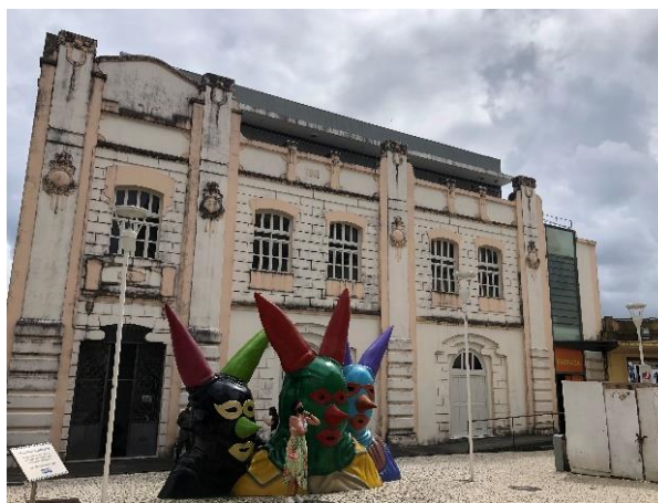
Figura 6.6 - Edifício 21. Acervo pessoal.
