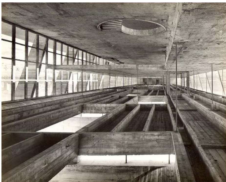
Figura 2.15 - Segundo pavimento do Museu ainda no processo construtivo, Centro de Documentação de Pesquisa do MAM, André Turazzi (CC BY-NC-AS) 1952, apud ARCHDAILY, 2014.
