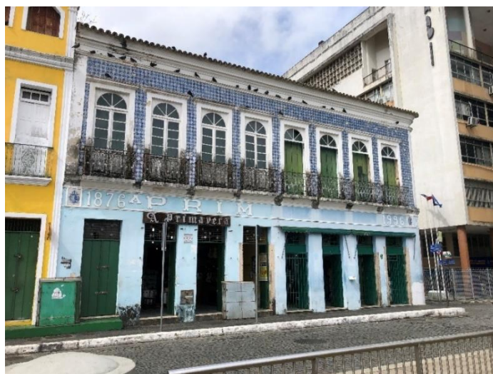
Figura 6.3 - Edifício 5. Acervo pessoal.
