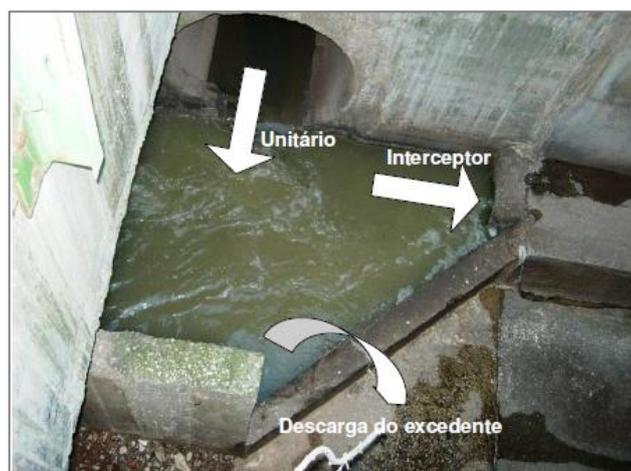
Figura 2.6 – Figura de um descarregador irregular (adaptado de Hidra et al., 2007).
