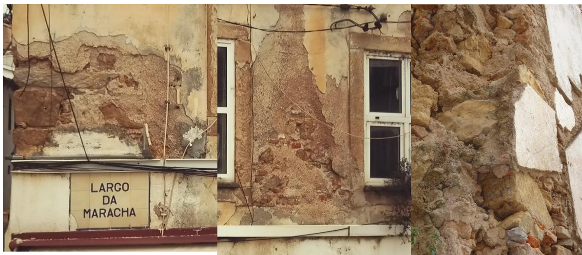
Figura 22: Material constituinte da parede de alvenaria da fachada do LM01 e RMO08.
