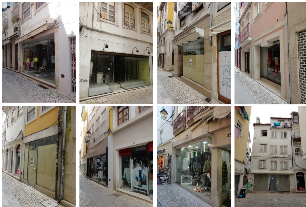
Figura 32: Alteração da tipologia original com grandes vãos no rés-do-chão
