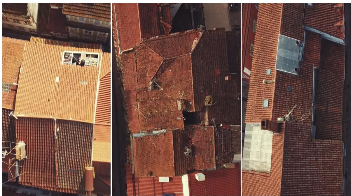
Figura 65: Coberturas associadas entre diferentes edifícios da Baixa de Coimbra.
