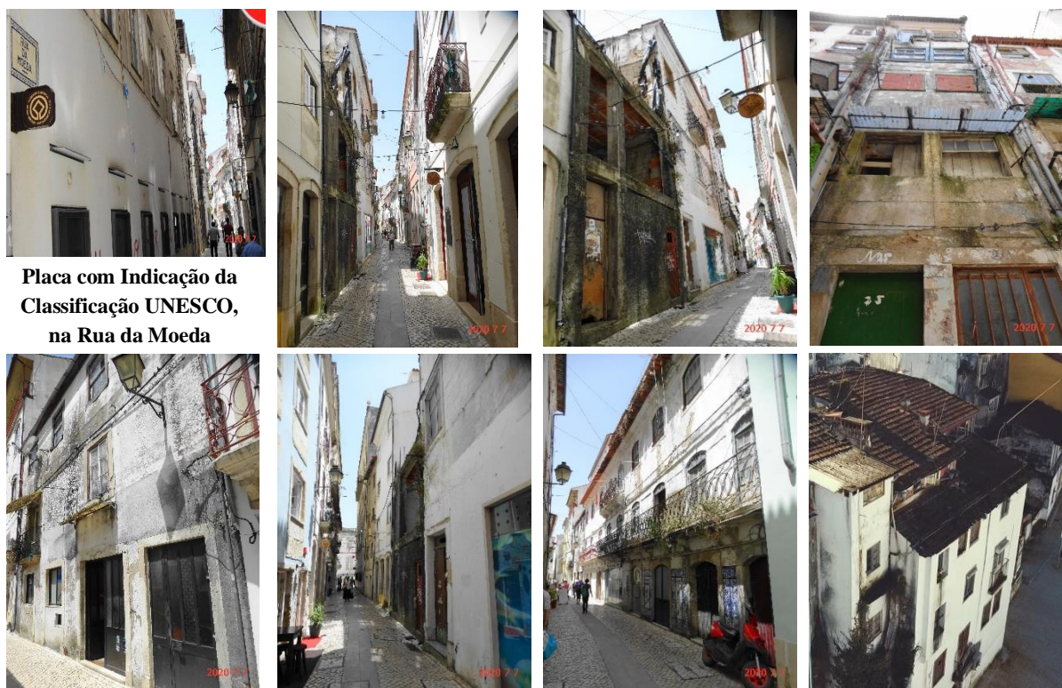
Figura 4: Vista para a Rua da Moeda, captada a 7 de julho de 2020
