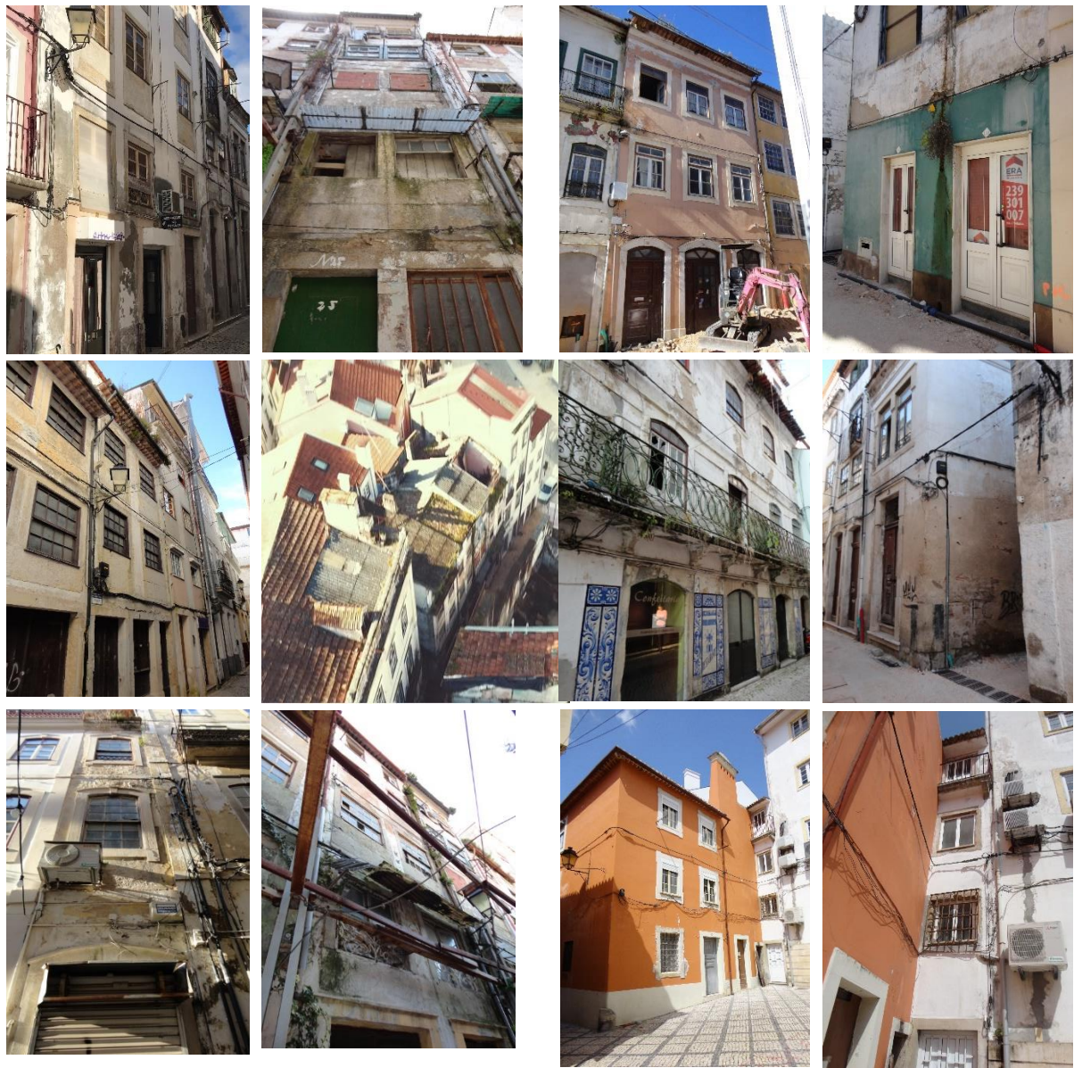
Figura 24: Estado de conservação, poluição visual das fachadas da Baixa de Coimbra
