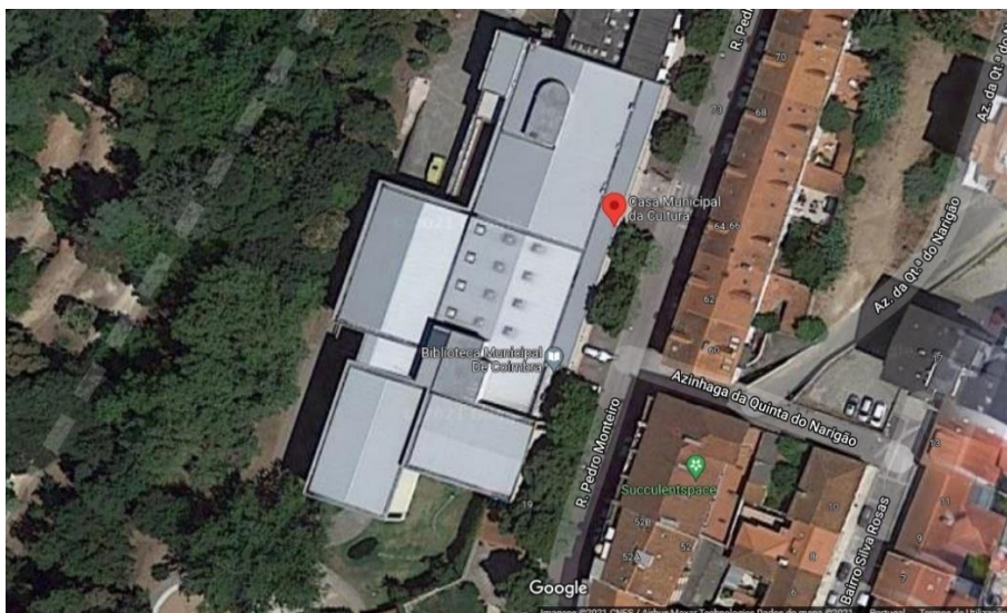
Figura 27: Cobertura do edifício da Casa Municipal da Cultura. [18]
