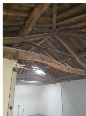
**Figura 3.5: Esquerda:** Estrutura da cobertura em madeira maciça espécie Castanho, (adaptado de (PORTO VIVO SRU, 2020)). **Direita:** Asnas pequenas com linha baixa e linha cima da cobertura do edifício caso de estudo
