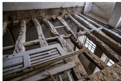
**Figura 3.3:** **Esquerda:** Vigamento de madeira do pavimento de Piso 1 (adaptado de (PORTO VIVO SRU, 2020)) **Direita:** Vigamento de madeira do Piso 2 (adaptado de (PORTO VIVO SRU, 2020))
