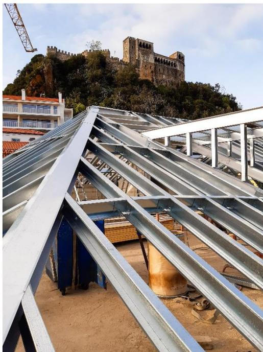
Figura 2.1 - Aplicação de perfis de aço enformado a frio na construção de uma cobertura
