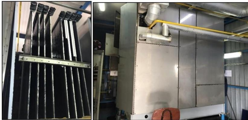
**Figura 3.6.** Vista interior e exterior do evaporador da máquina de gelo da lota de Aveiro.
