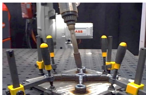
Figura 4.8 – Posicionamento da tocha de soldadura no fabrico da peça final
