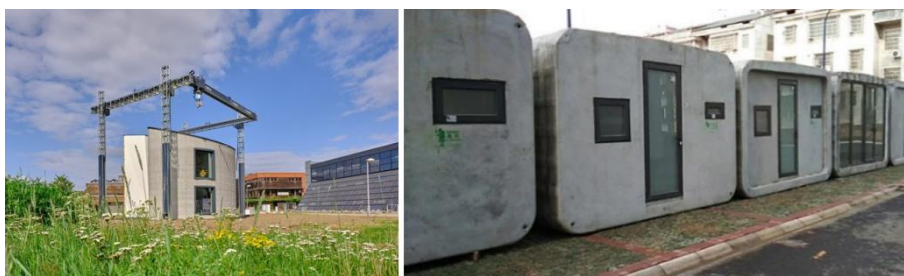
Figura 2.2 – Casas realizadas por Fabrico Aditivo
