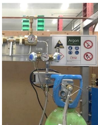
Figura 4.4 – Instalação do gás de proteção
