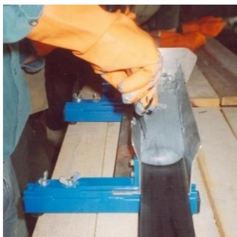
Figura 2.12 – Aplicar a resina no laminado (S&P@, 2020).
