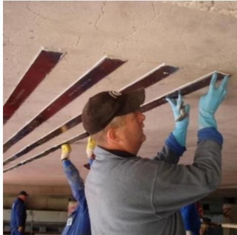
Figura 2.13 – Aplicação do CFRP (S&P@, 2020).
