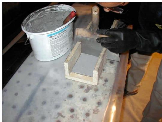
Figura 2.7 –Aplicação da resina para colagem de um laminado de FRP (STAP@, 2018).
