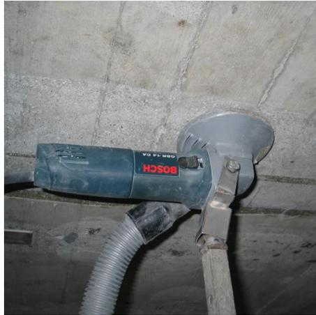
Figura 2.8 – Preparação da superfície (S&P@, 2020).
