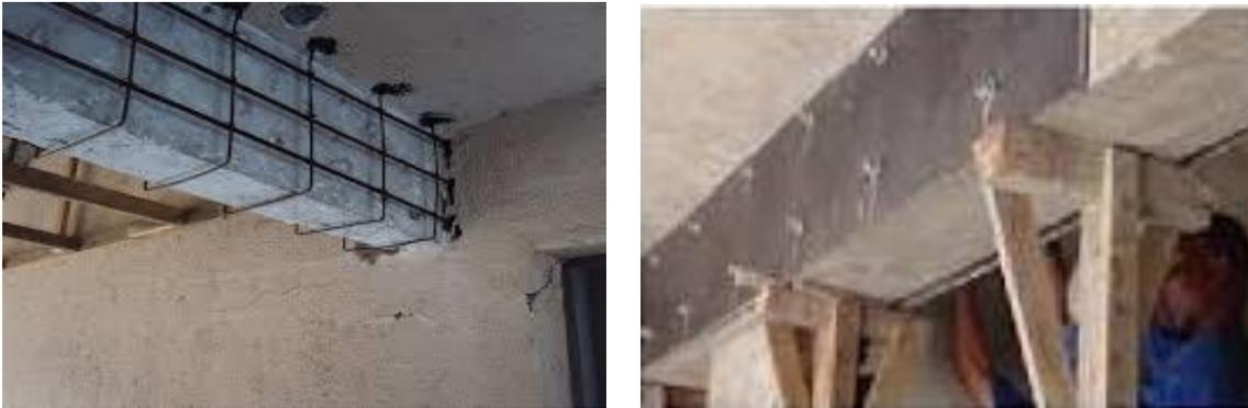
Figura 2.1 – Reforço de estruturas de betão armado tradicionais – Encamisamento de betão armado (Techniques, 2013) e com chapas metálicas (Rodrigues, 2005).
