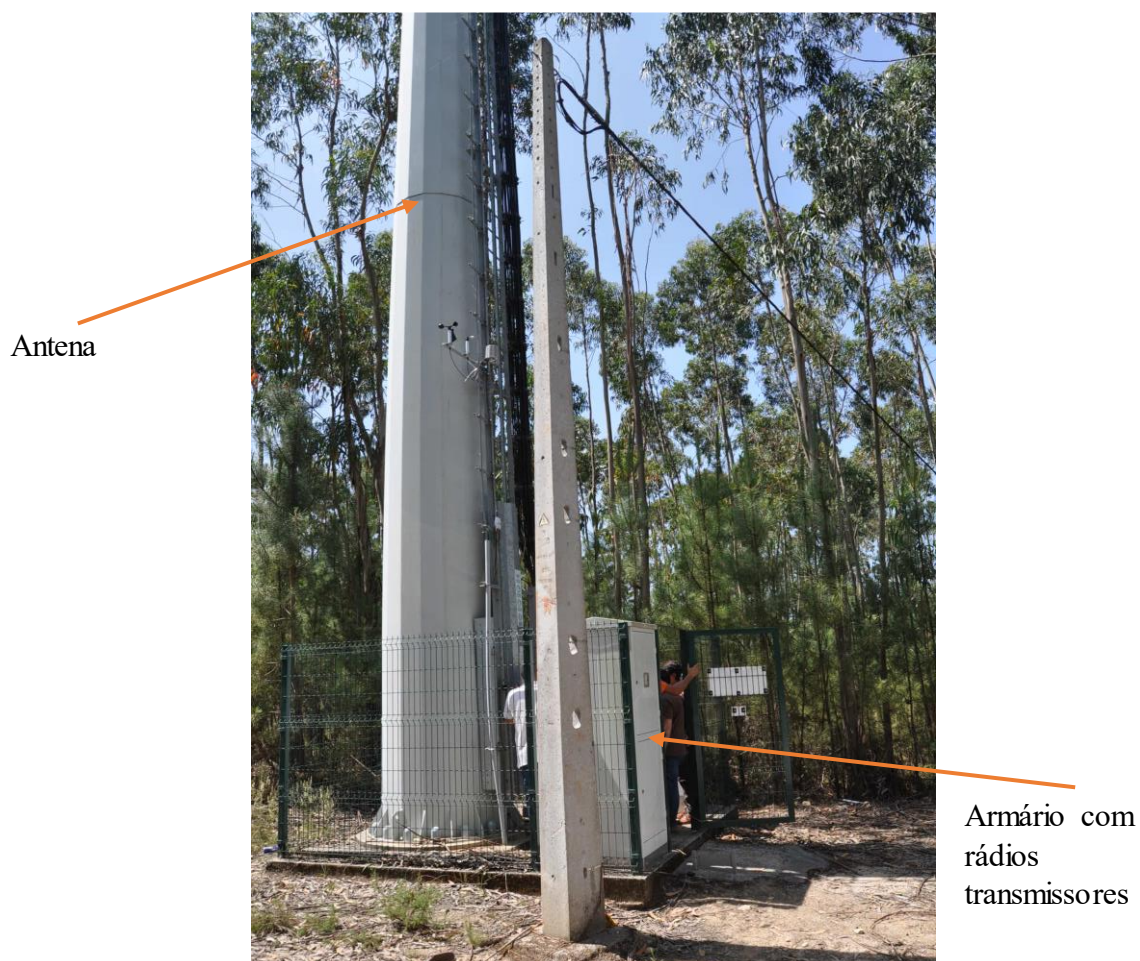
Figura 1.3. Estação de rádio de Rio Vide
