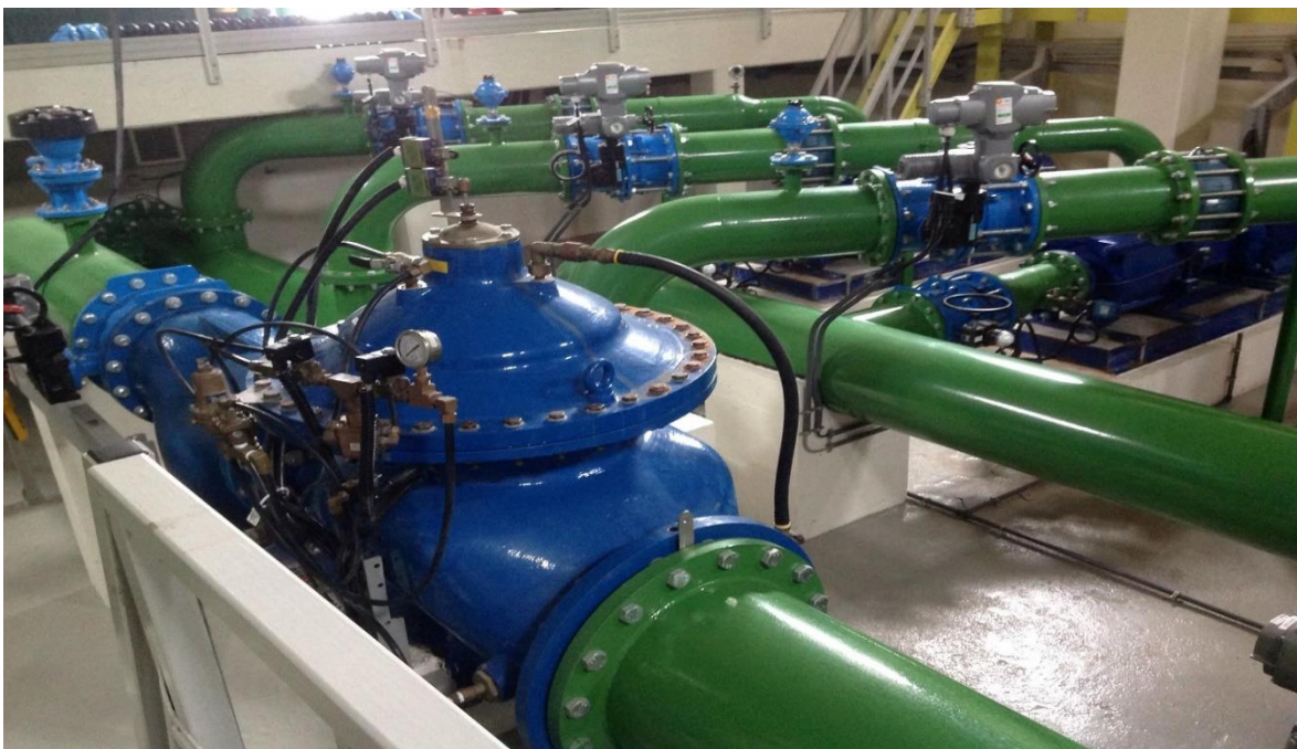
Figura 4.3 – Vista do interior de uma Estação Elevatória
