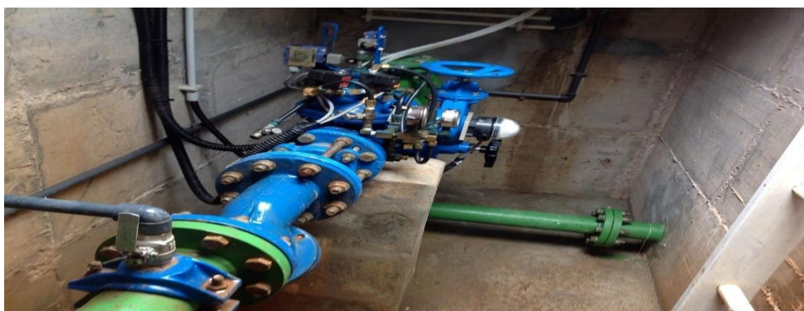
Figura 4.5 – Vista interior de um Ponto de Entrega
