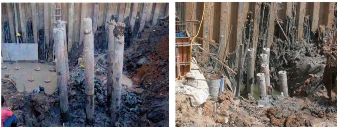
**Figura 3 - Danos nas estacas devido ao efeito Tschebotarioff verificados por Kok *et al.* (2009b): rotura devido a uma escavação (Kok *et al.* 2009b)**
