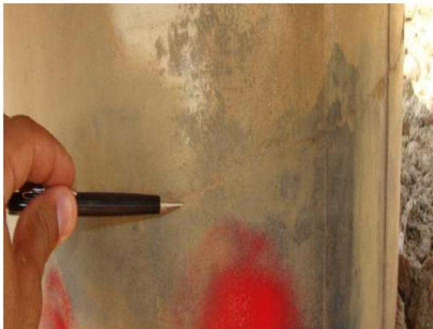
**Figura 4 - Fissuras no topo da estaca devido ao efeito Tschebotarioff (Retirado de Polido, 2015)**
