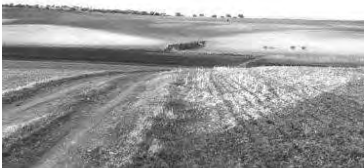
13 – Moralves (30) : vista geral do paredão da barragem
