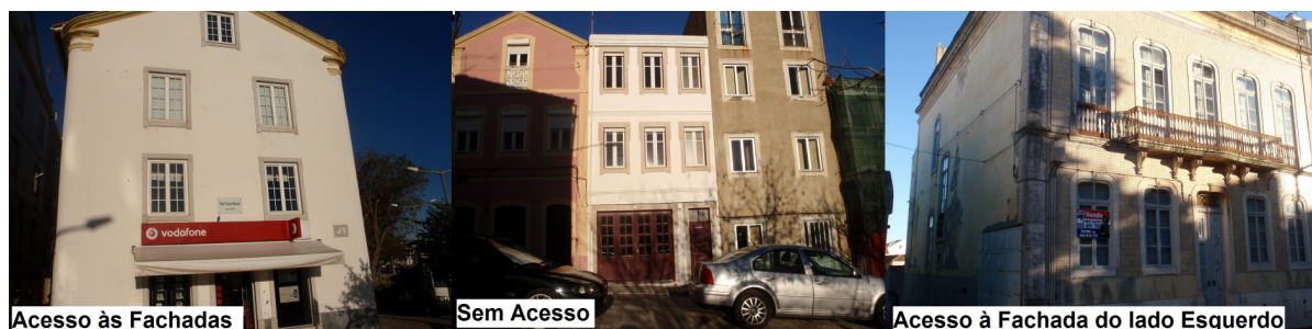
Figura 15 - Caracterização do Acesso às Fachadas
