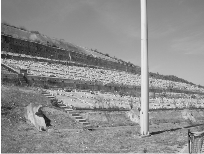
Figura 4.29 - Muro ancorado. Praça da portagem A1 - Alverca. Créditos fotográficos A. Saraiva.
