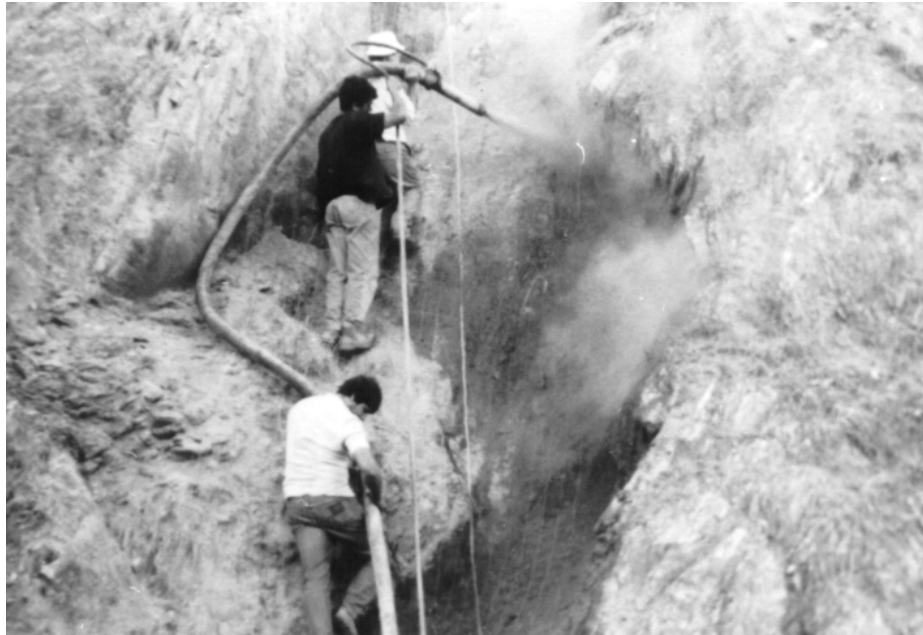
Figura 4.35 - Aplicação de betão projectado, por via húmida, numa caixa de falha.
