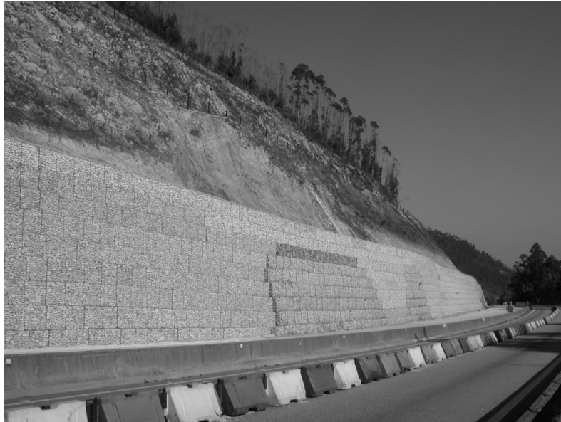
Figura 4.31 - Muro de gabiões IP3, km 61. Créditos fotográficos A. Saraiva.
