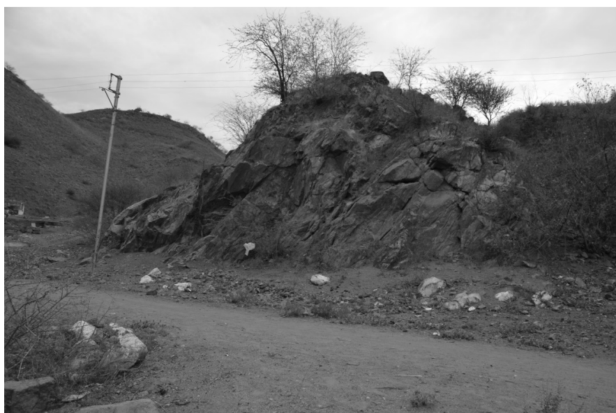
Figura 5.7 - Talude 4 junto à ponte da Povoação sobre o Rio Catumbela.
