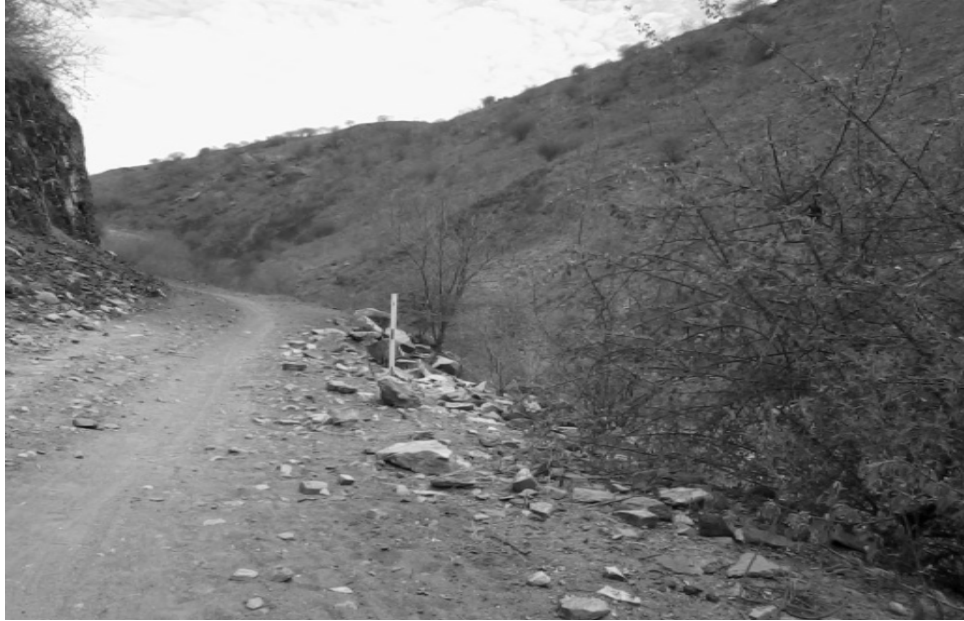
Figura 5.4 - Talude 3 ao longo da picada nas proximidades da ponte da Povoação.
