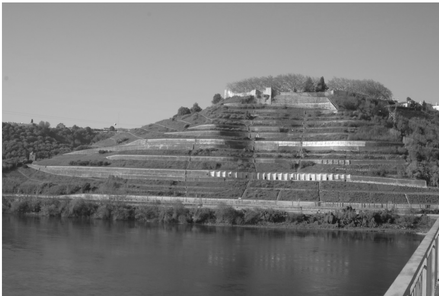
Figura 4.27 – Obras de estabilização na encosta das Portas do Sol, Santarém. Créditos fotográficos A. Saraiva.
