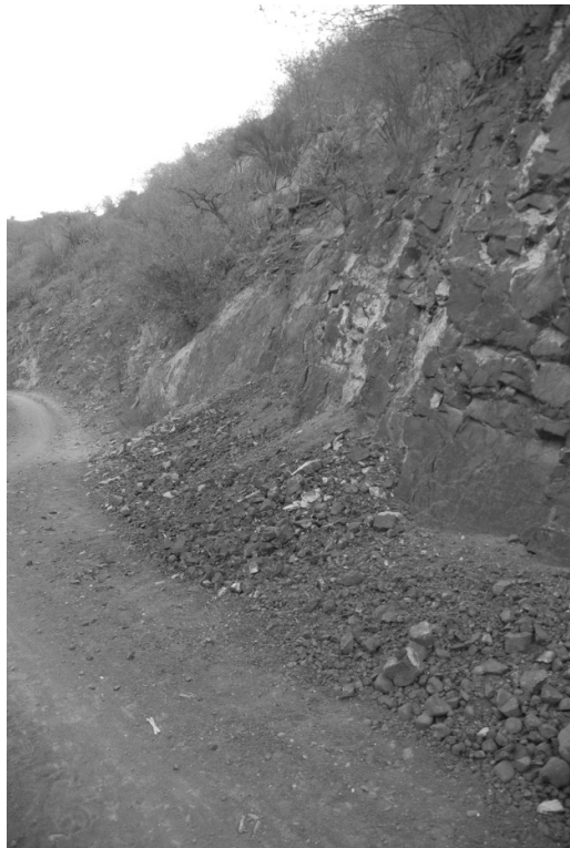
Figura 5.5 – Cones de dejeção no talude 3.
