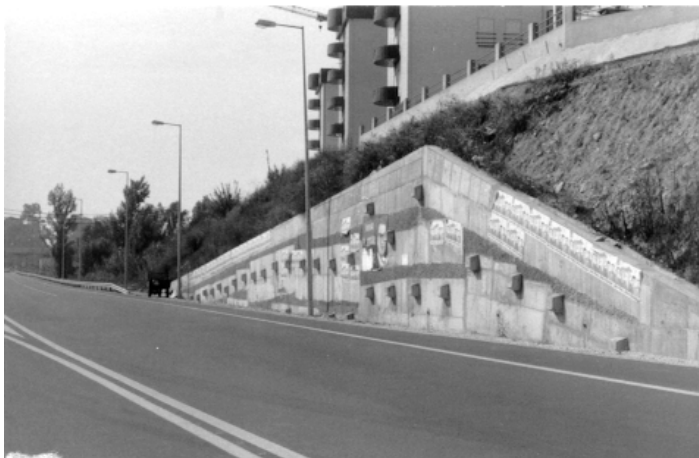
Figura 4.28 - Muro ancorado (Coimbra).
