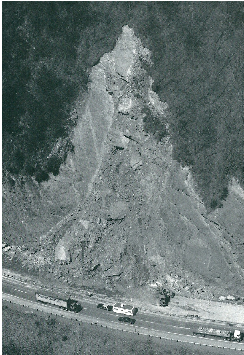
Figura 4.16 – Deslizamento em cunha na I-40, Tennessee, EUA (Moore, (1986)
