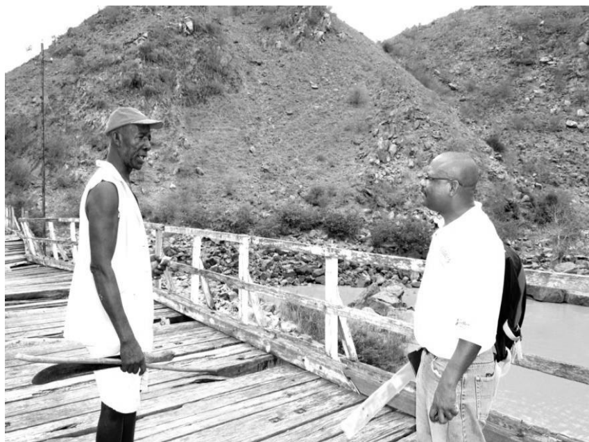
Figura 1.1 - Ponte da povoação do Biópio-Açucareira 1º de Maio.
