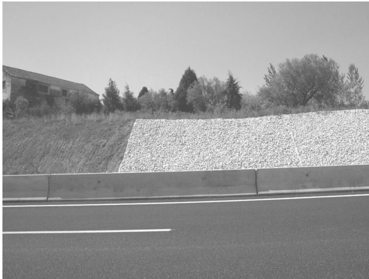
Figura 4.26 - Máscara drenante na A8. Créditos fotográficos A. Saraiva.
