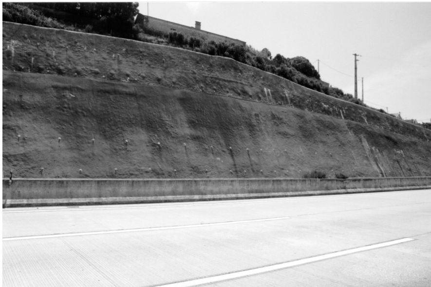
Figura 4.36 - Betão projectado e drenos sub-horizontais (CREL).
