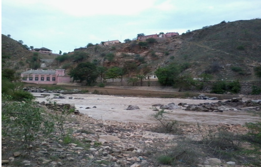
Figura 5.8 – Vista global do talude 5 nas imediações da zona urbana da Comuna da Catumbela Povoação do Biopio- Açucareia 1º de Maio.
