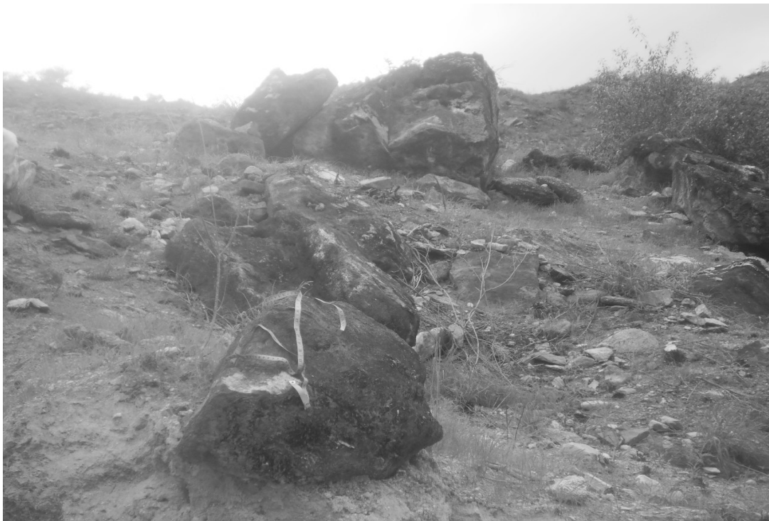
Figura 5.16 - Instabilização devida à movimentação de blocos de rocha.
