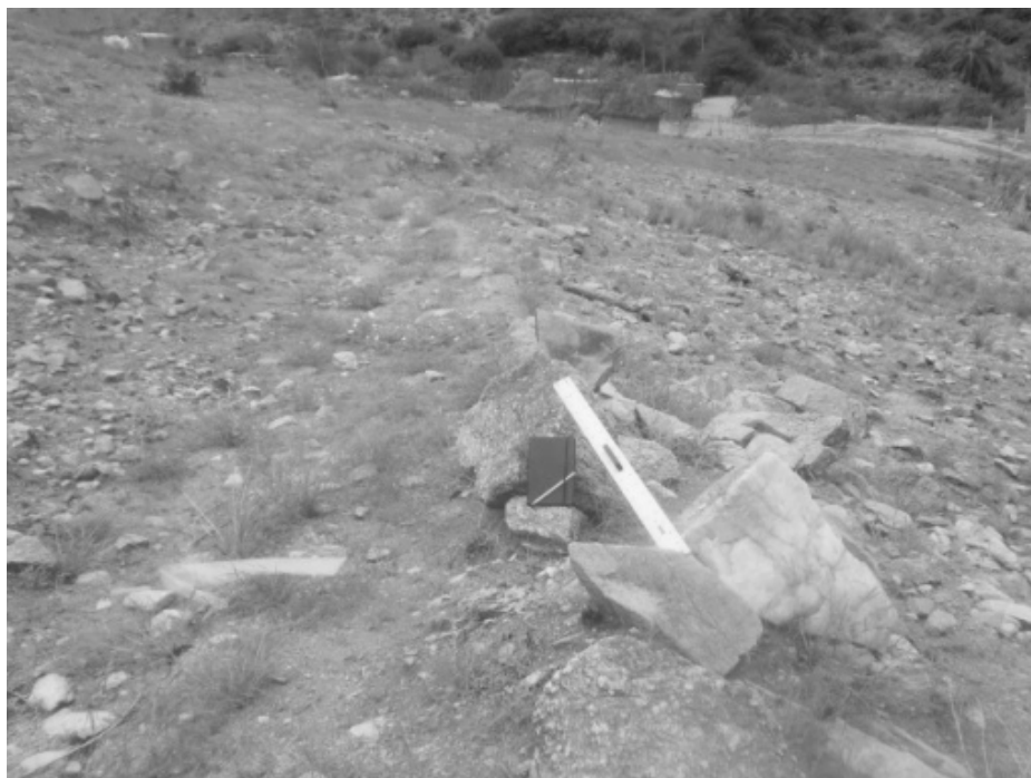
Figura 5.15 -Talude 9 junto à localidade de Camuringue da ponte.
