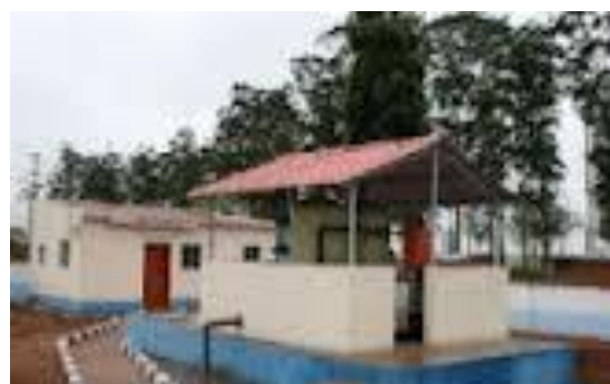
Fig. 2.20 – Equipamento ambiental na Sede (estação de tratamento de água).
