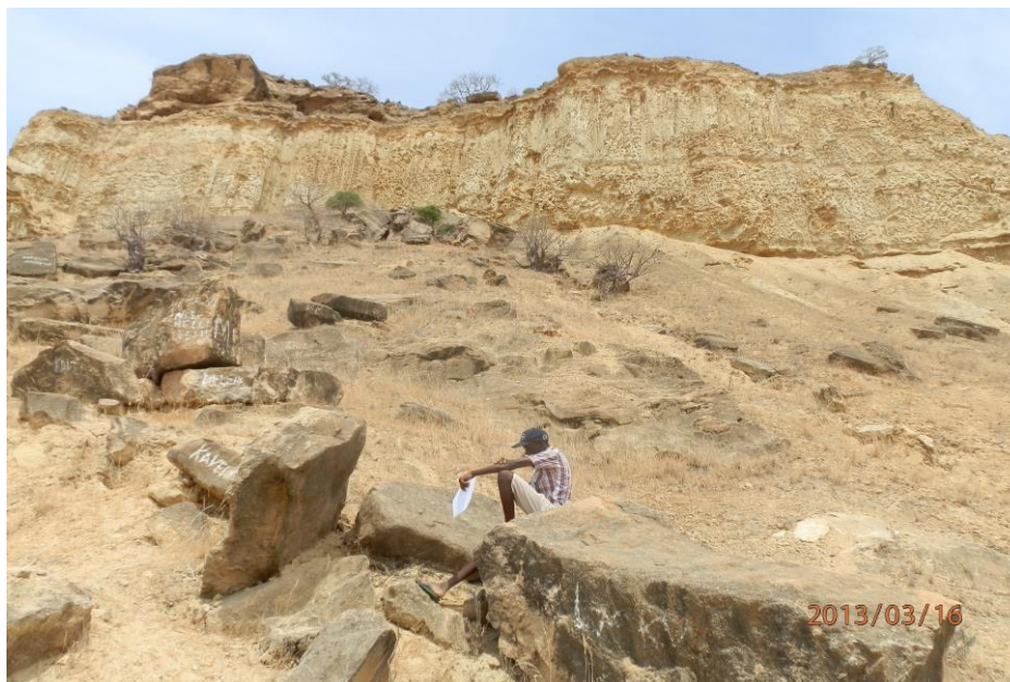
Figura 3.4 – Resultado do movimento de queda de blocos na área da Caota.
