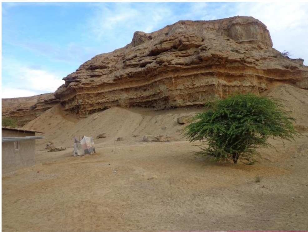
Figura 5.9 – Representação fotográfica do Talude 4.
