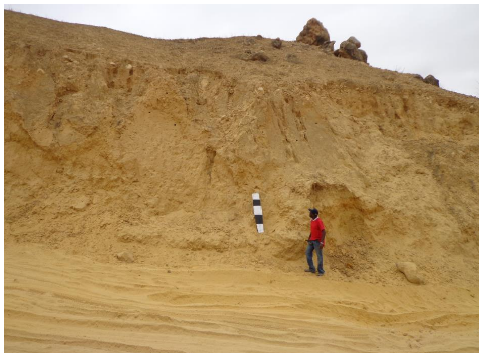
Figura 5.2 – Talude 1, em que são visíveis processos erosivos e situações de instabilidades como a queda de blocos e deslizamentos.
