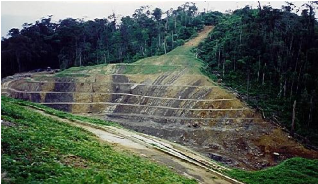
Figura 3.10 - Modificação da geometria de um talude (Andrade, 2011).
