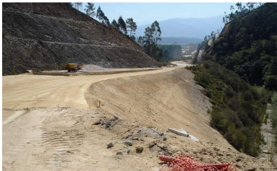
Figura 3.3 - Talude de aterro (Andrade, 2011).
