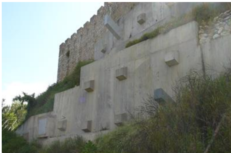
Figura 3.13 - Muro de contenção ancorado (Andrade, 2011).
