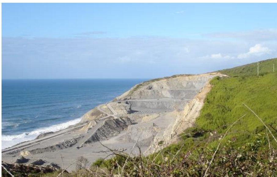
Figura 3.2 - Talude de escavação no Cabo Mondego (Andrade, 2011).
