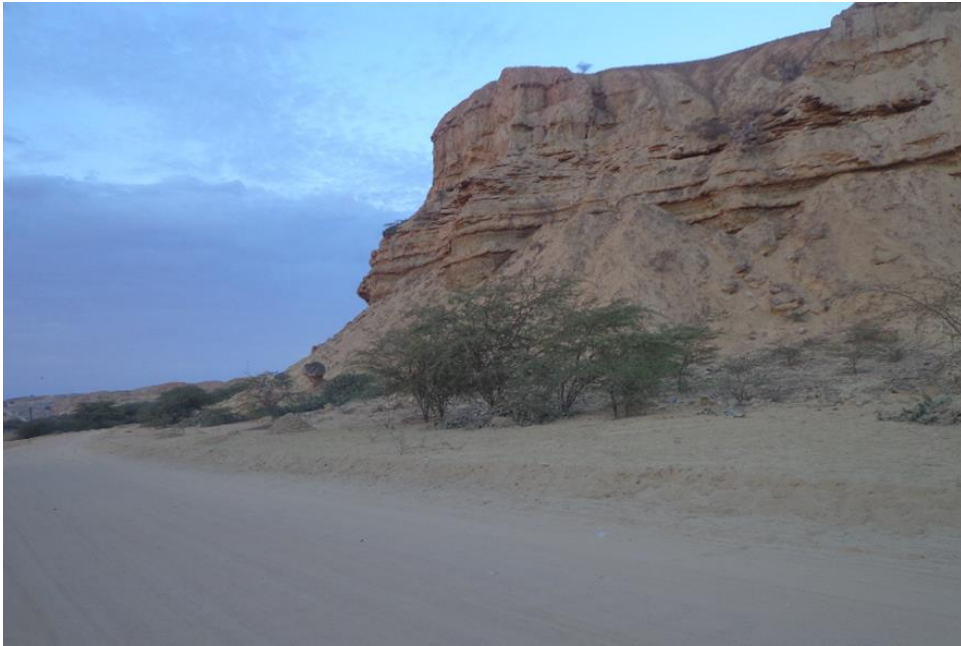
Figura 5.11 – Representação fotográfica do Talude 5.
