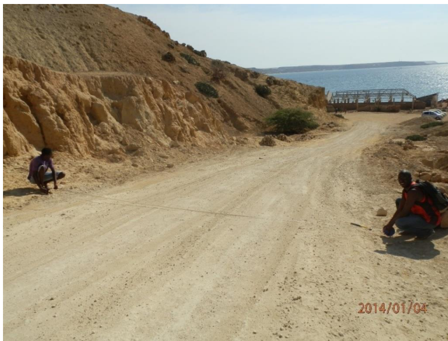
Figura 4.3 - Medição da largura da via de comunicação do Talude 1- troço 1.
