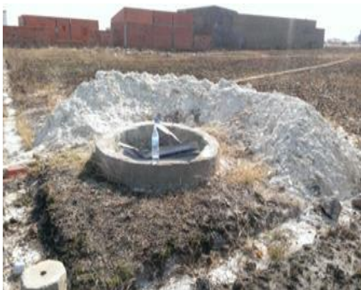
Figura 16a. Material argiloso retirado aquando da escavação do poço PA3.
