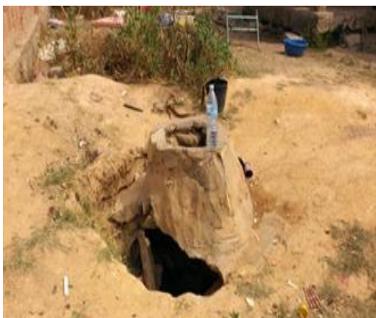
Figura 10 a. Poço sem proteção adequada.
