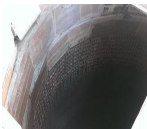
Figura 11b. Interior do poço - CH7.
