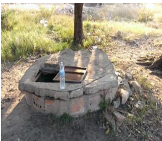
Figura 11a. Poço com proteção adequada . CH7.
