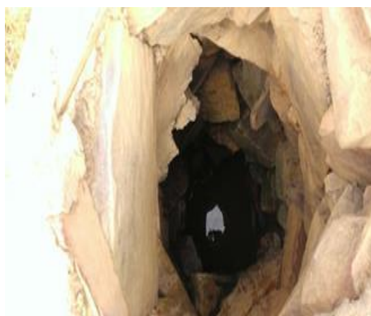
Figura 10 b. Interior do poço - CV3.
