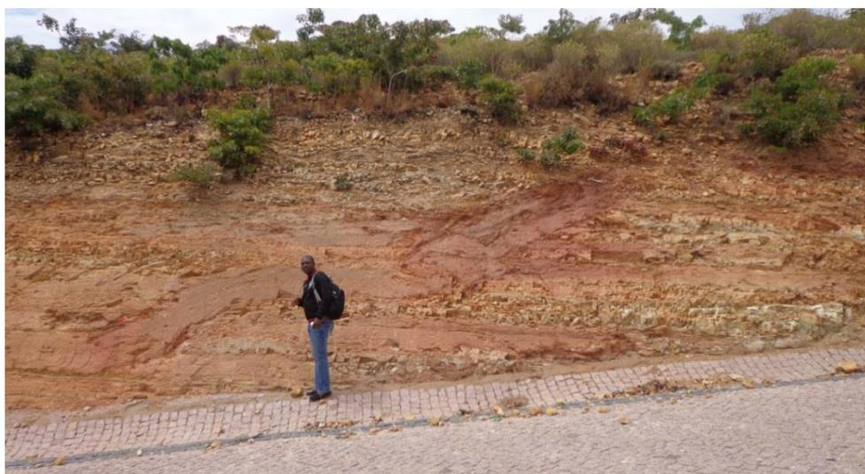
Figura 5.1 – Troço 2 do Talude 1, em que são visíveis as diferentes litologias e as situações de instabilidades como a queda de blocos.
