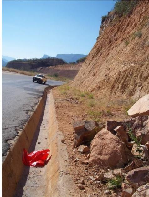
Fig. 4.5– Representa a capacidade de retenção da valeta.
