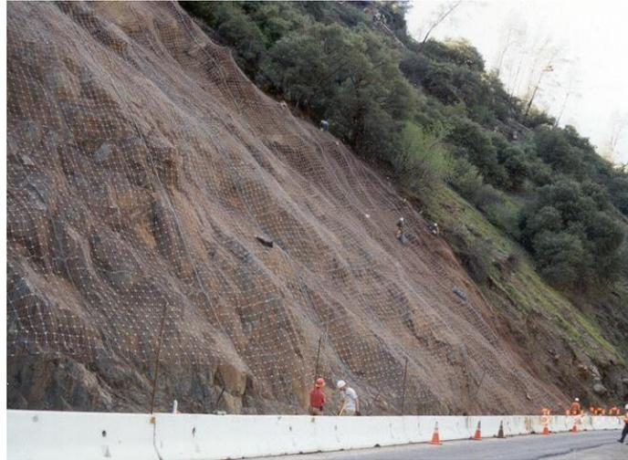
Figura 2.12 – Rede de protecção metálica (retirado de Andrade (2008)).
