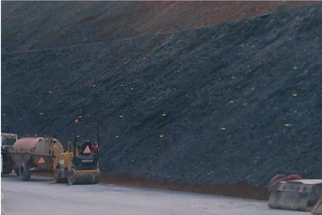
Figura 4.10 – Talude 1, zona B, localizado à saída da A13.
