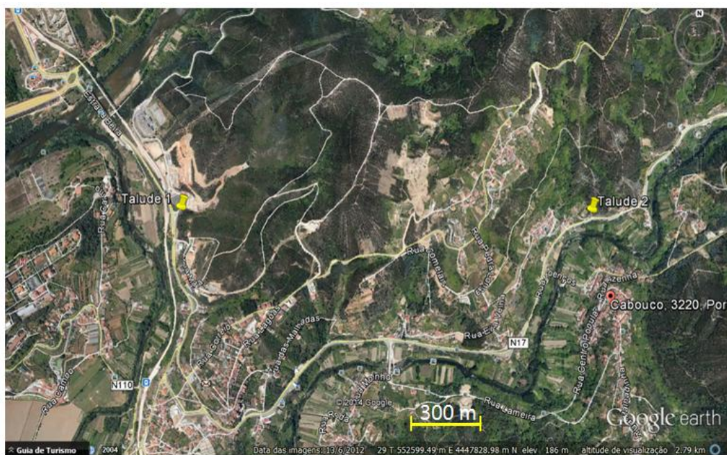
Figura 4.5 – Vista geral dos dois taludes (Google earth, 2014)
