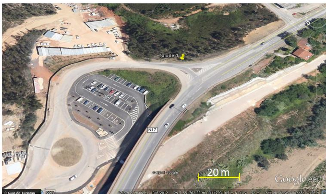
Figura. 4.6 - Localização do Talude 1 (Google earth, 2014)
