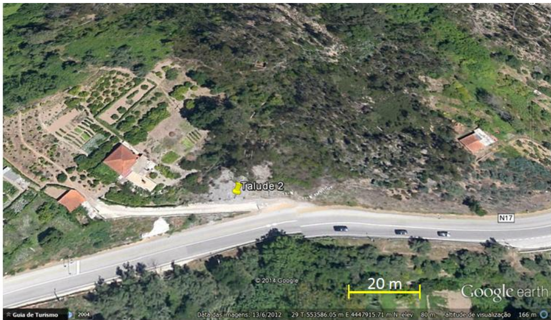
Figura. 4.7 - Localização do Talude 2 (Google earth, 2014)
