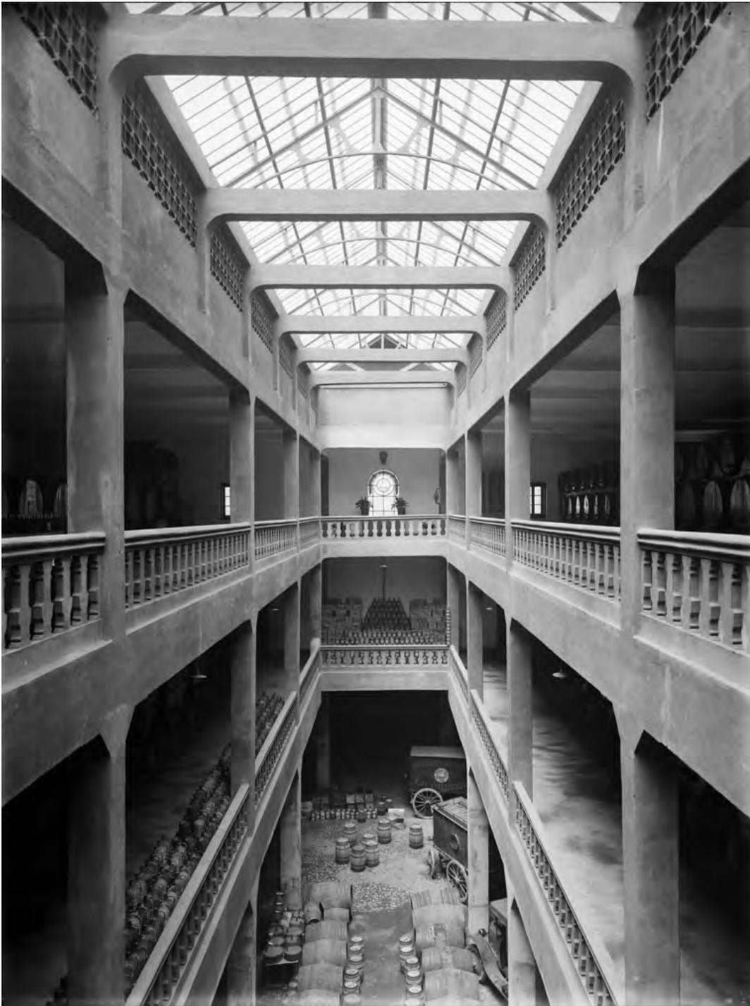
Fig. 89 - Galeria de betão armado - iluminação feita através do lanternim no centro
