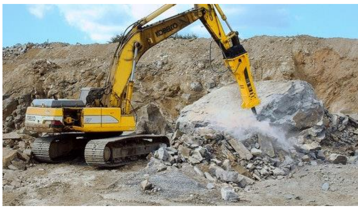
Figura 8 - Exemplo do processo de taqueamento efetuado por um martelo hidráulico
