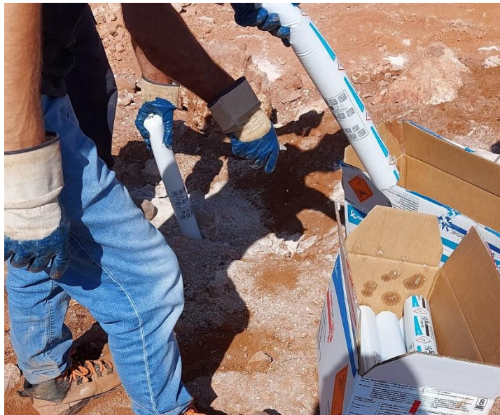
Figura 26 - Manuseamento Explosivos
