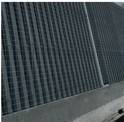
Figura 2.8 - Barreira acústica em betão com incorporação de borracha (fonte: https://www.jornaldenegocios.pt/negocios-iniciativas/detalhe/barreiras-acusticas-de-borracha-mais-eficazes ).
