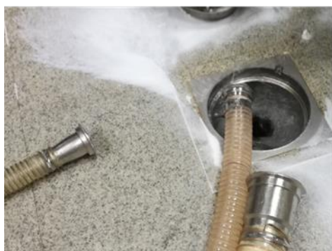
Figura 4.35 Descarga dos tubos da GH2 e respetiva proposta de caixa de escoamento
