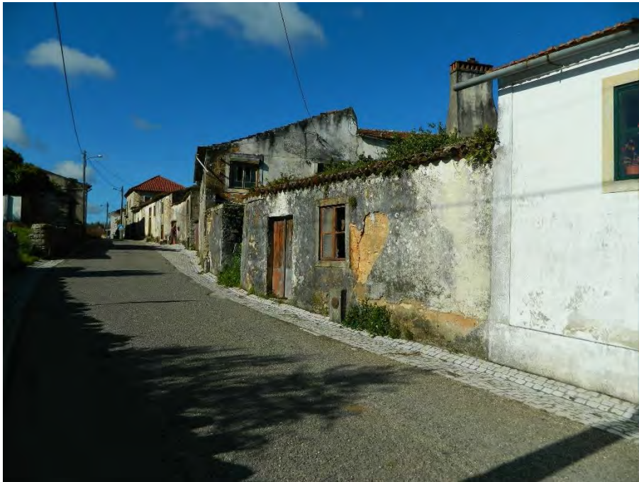
Figura 59 - Estado atual do edifício onde se instala a Sala da Comunidade.
