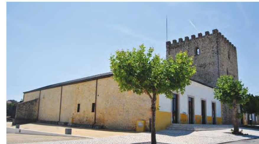
Figura 21- Complexo Monumental de Santiago da Guarda
