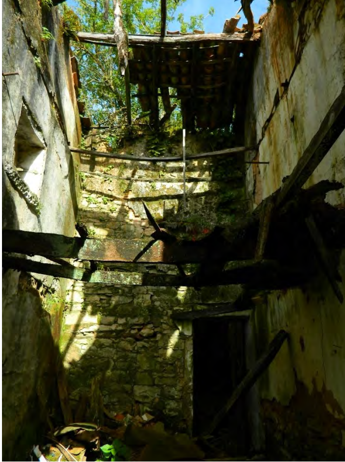
Figura 63 - Estado atual do edifício onde se instalou o estúdio.
