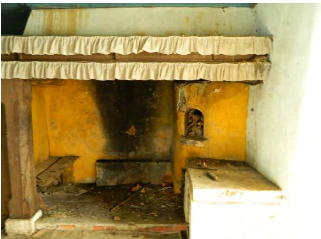
Figura 58 - Fotografias do estado atual da antiga Casa Paroquial.
