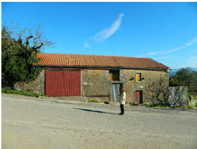
Figura 48 – Estado de Conservação de alguns edifícios de Pombalinho.
