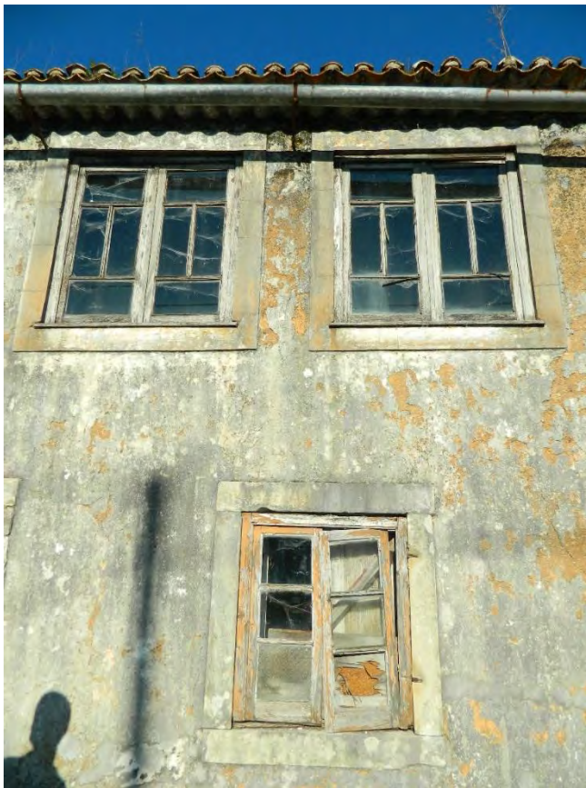
Figura 68 - Caixilhos em madeira existentes
