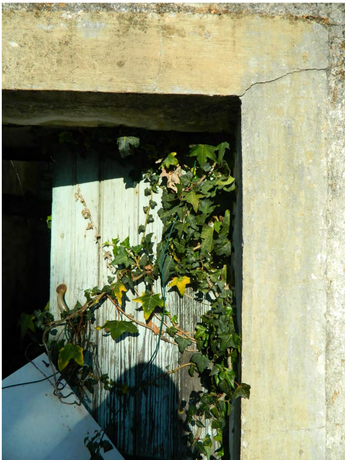
Figura 69 - Pormenor da porta existente.
