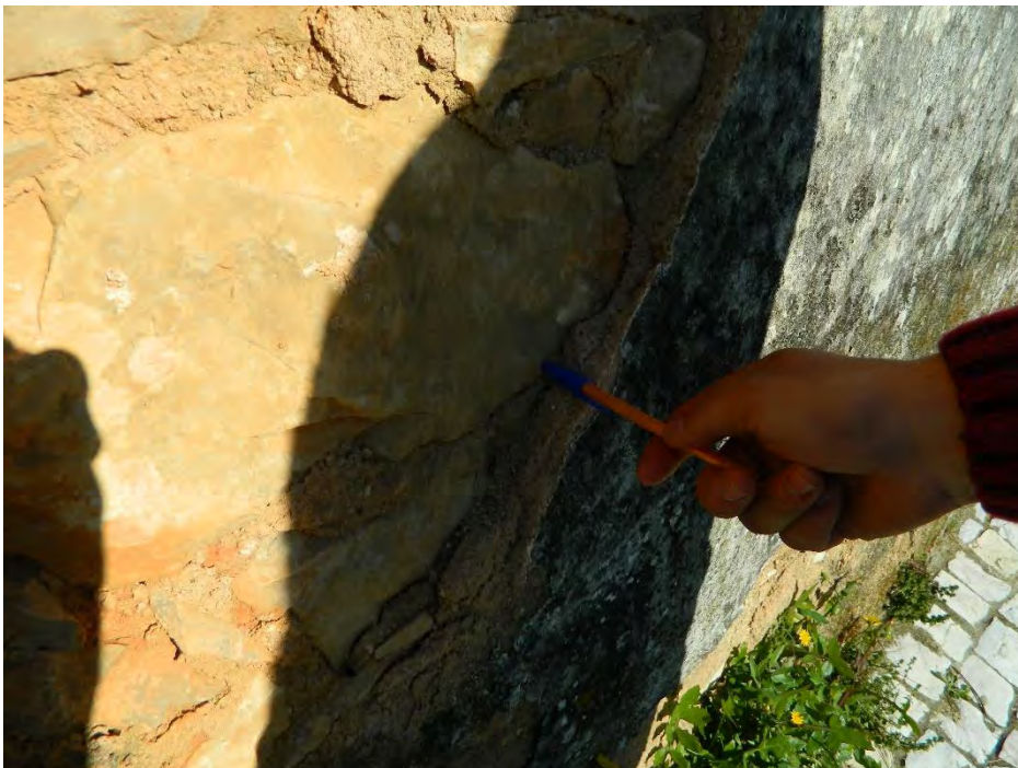
Figura 66 - Troço de parede existente em alvenaria de calcário e reboco.
