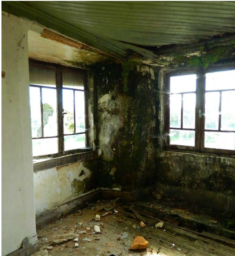
Figura 61 - Estado atual da antiga Casa Paroquial.
