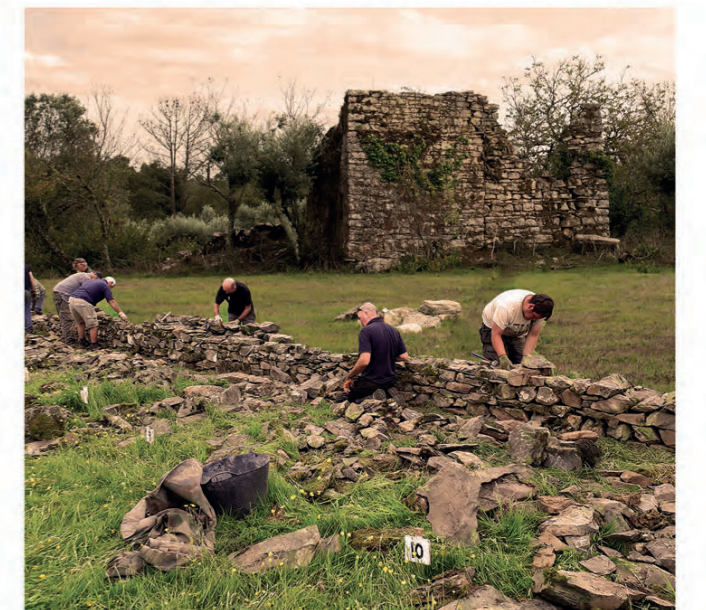
Fotomontagens da reconstrução de um muro de pedra seca.
