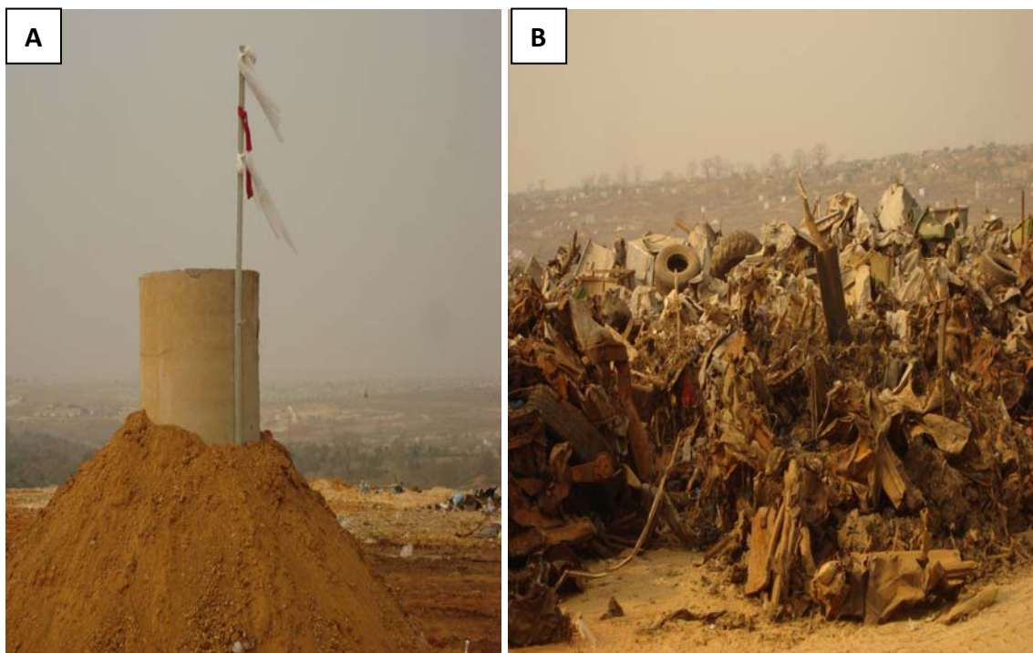
Fig. 2.8: Uma chaminé do aterro sanitário de Luanda, próximo a um assentamento populacional (A) e resíduos ferrosos e outros depositados a céu aberto município do Cazenga (B) (fotos do autor).
