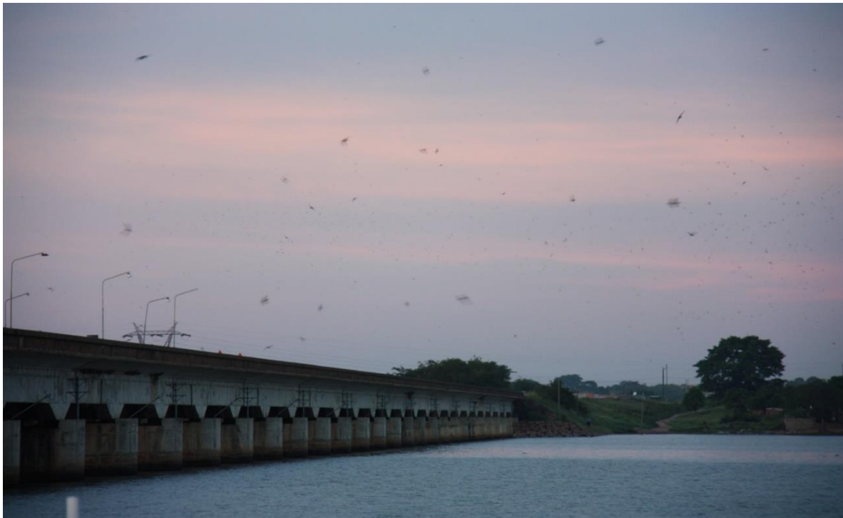
Figura 1.1 - Vista de montante da barragem da Matala.
