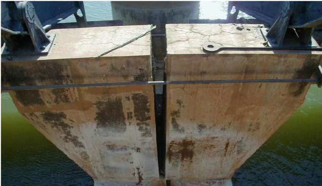
Figura 5.6 - Aberturas das juntas dos pilares (Batista e Gomes, 2014).
