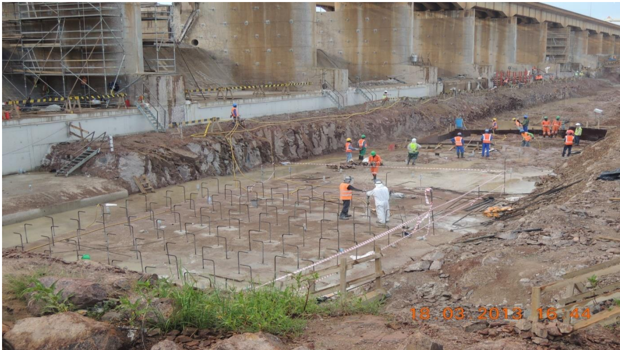
Figura 1.3 - Obras de reabilitação da barragem da Matala
