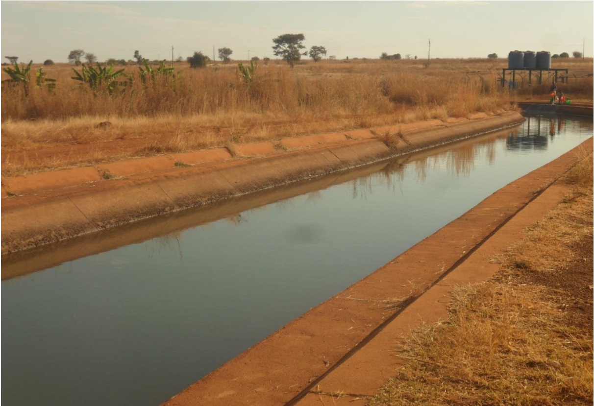
Figura 2.1- Canal de irrigação da Matala
