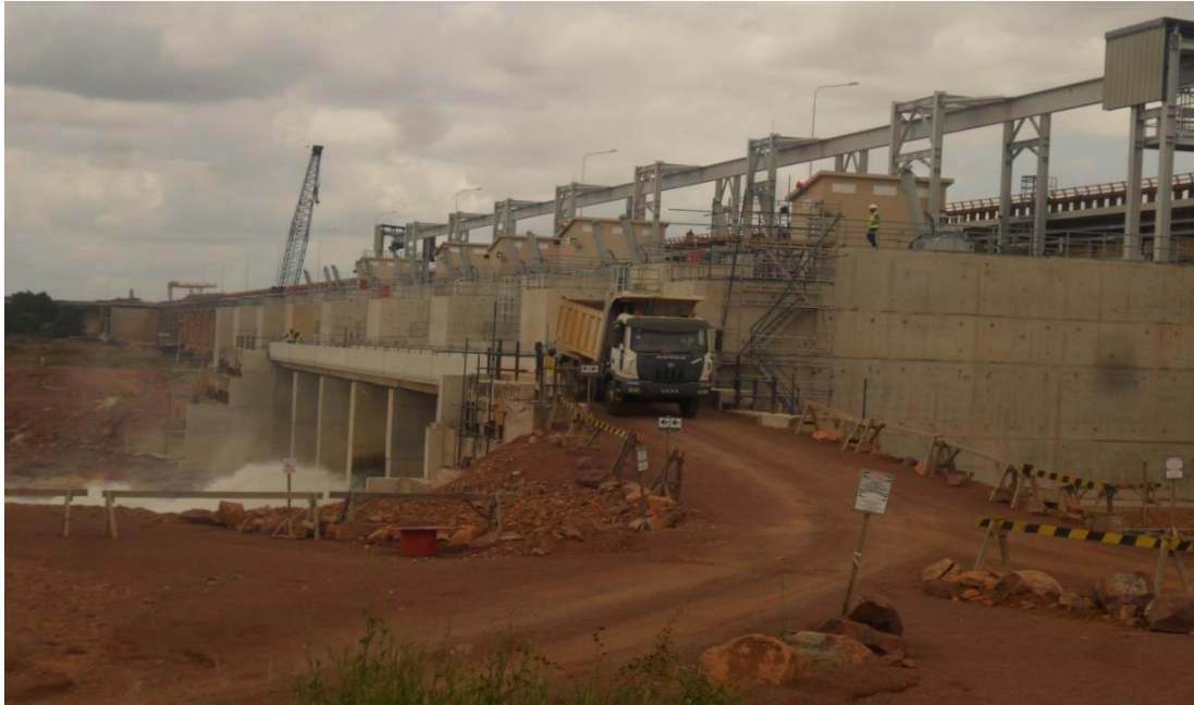
Figura 5.10 - Solo avermelhado utilizado na construção de pistas para a movimentação de veículos e utilizada durante os trabalhos de reabilitação da barragem da Matala.
