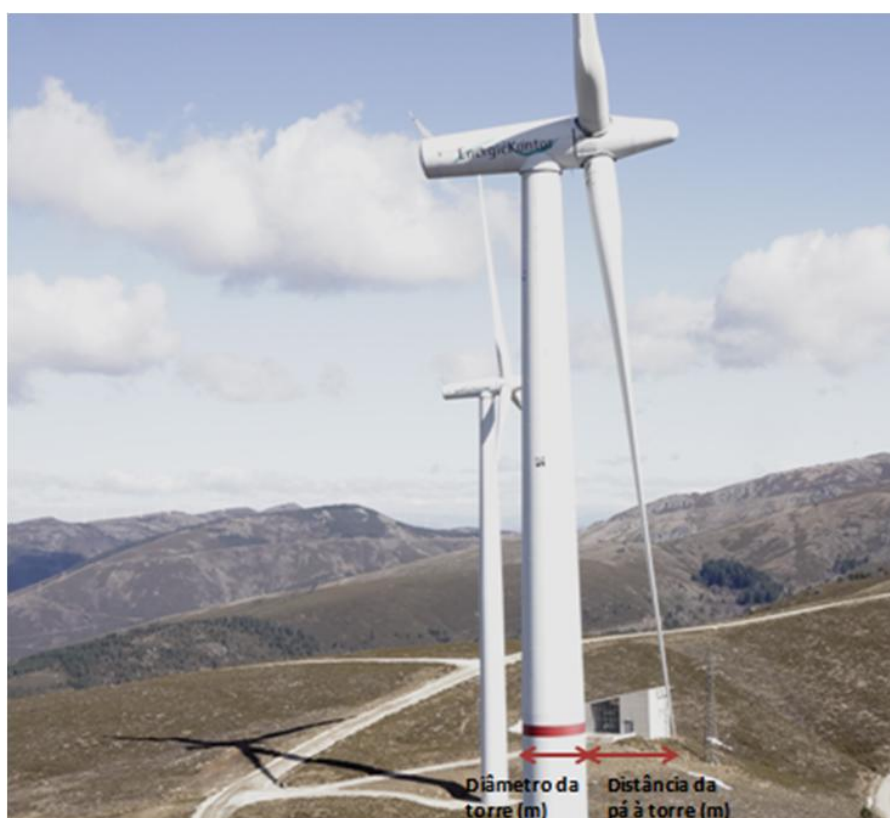
Figura 4.20 – Pormenorização dos dados essenciais à análise das pás eólicas.
