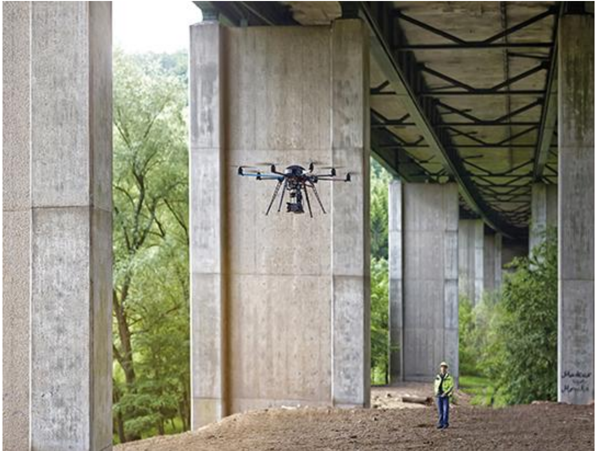
Figura 2.18– Inspeção estrutural de uma ponte através de um drone (IZFP, 2014).
