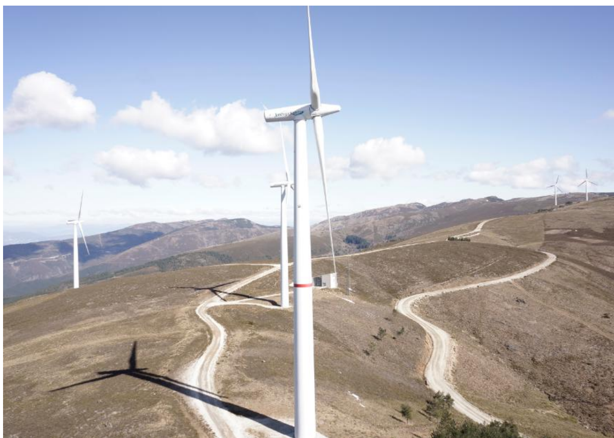
Figura 4.19– Torre eólica analisada.
