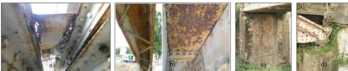
Figura 4. 3- a) Fenómeno de corrosão nas placas entre vigas; b) Fenómeno de corrosão no interior das vigas metálicas; c) Crescimento da vegetação junto de um dos encontros; d) Crescimento de vegetação no topo de um dos encontros.
