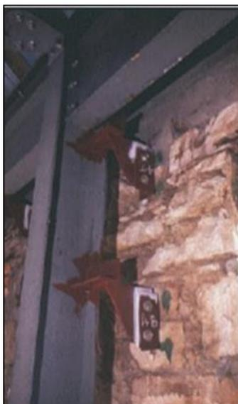
Figura 2. 11- Coluna vertical de aço fixada em coluna de alvenaria (Correia, 2012).
