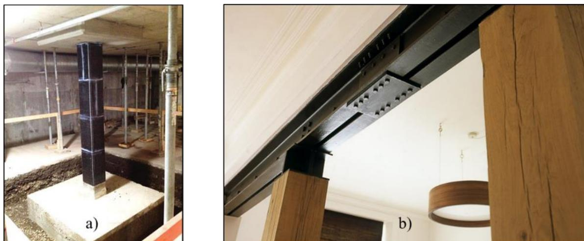
Figura 2. 13- a) Pilar de BA reforçado com fibras de carbono (CompositesWorld@, 2014); b) Viga de aço reforçada com fibras de carbono (Brewdog@, 2013).
