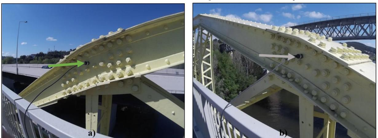
Figura 3. 7- a) Posição do acelerómetro nos *setups* realizados nos arcos da ponte; b) Posição do acelerómetro nos *setups* realizados nos arcos da ponte.
