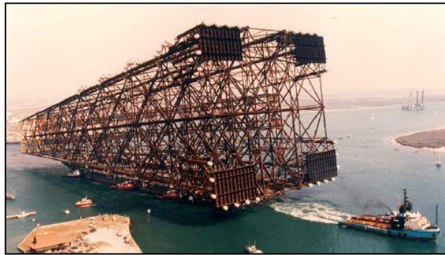
Figure 1.0.1- Jacket structure (J. Wardenier et al, 2010).
