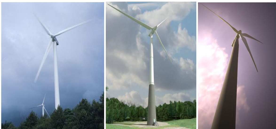
Figura 2.4- Exemplos dos tipos de torres existentes. À esquerda- de aço (ArcelorMittal), ao meio- híbrida (REVE, 2013), à direita- de betão armado pré-fabricado (Ecoventia)
