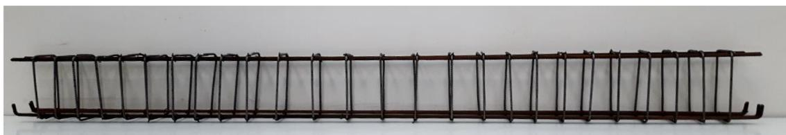
Figura 3.2- Exemplo de armadura de uma viga.
