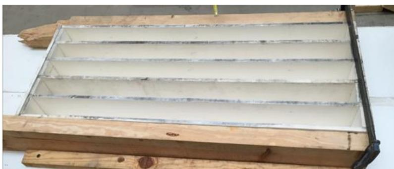
Figura 3.4- Cofragem utilizada na construção das vigas.
