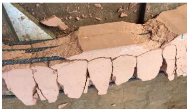
Figura 4.29 - Aspeto final da Viga S0.
