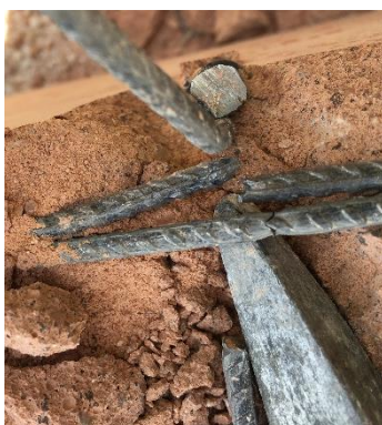
Figura 4.51 - Modo de rotura da Viga \beta 4\phi 4 .
