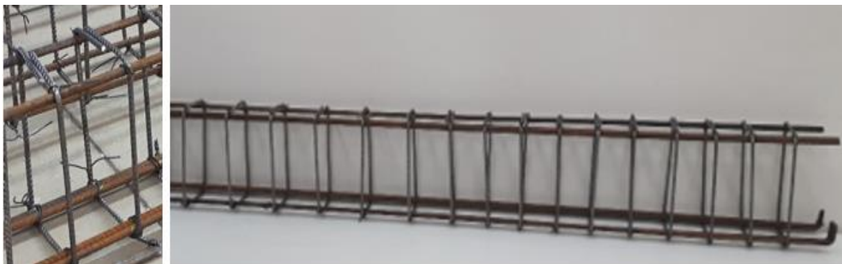
Figura 3.2 - Detalhes da armadura de uma viga tipo.
