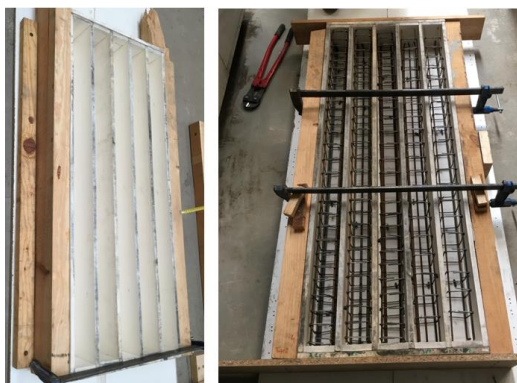
Figura 3.3 - Cofragem utilizada na construção das vigas.
