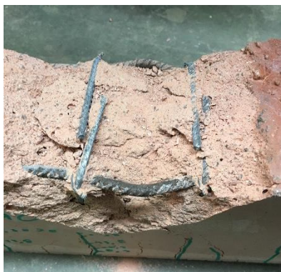
Figura 4.7 - Modo de rotura da Viga R64φ8.
