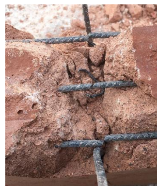
Figura 4.52 - Modo de rotura da Viga \beta 3\phi 4 .
