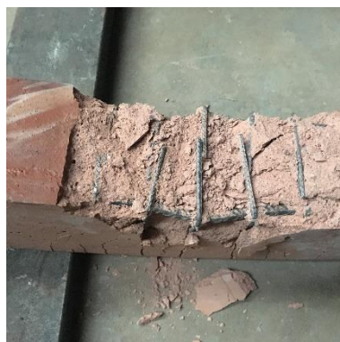
Figura 4.30 - Instabilização das armaduras de compressão e estribos da Viga S4.
