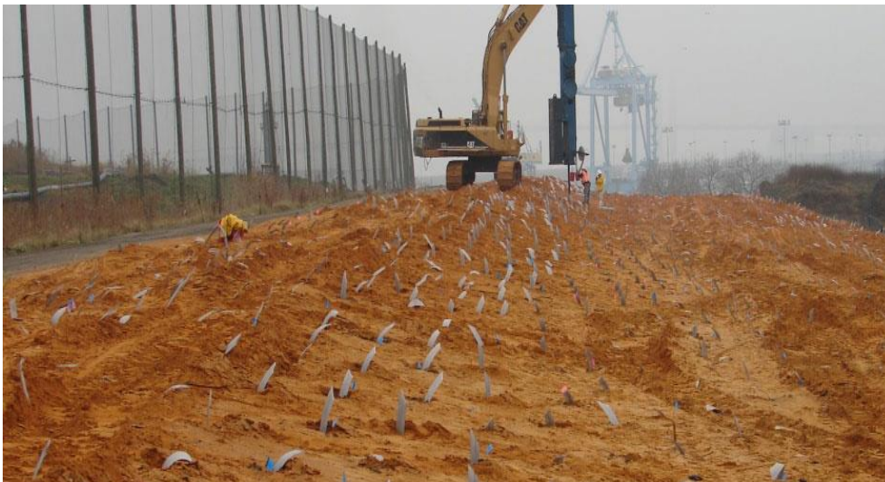
Figura 2.2 – Fase de colocação de drenos geossintéticos em obra (fonte:www.igeotecnia.com).
