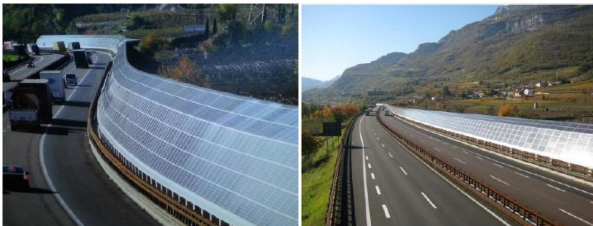
Figura 3.13 – Barreira acústica inteligente construída na auto-estrada italiana A22 (retirado de Natale e Luzzi, 2013)
