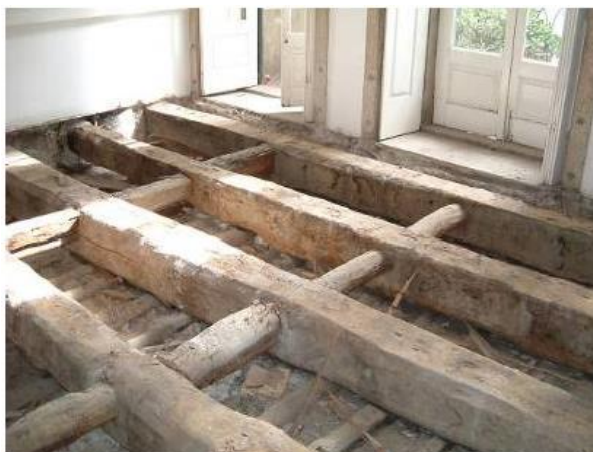
Figura 1.1 – Vigamento efetuado por troncos falqueados (toro esquadriado, em que a seção é aproximadamente retangular) (Dias, 2008)
