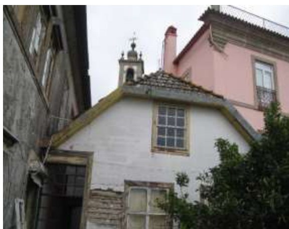
Figura 16 – Anexo da casa.
