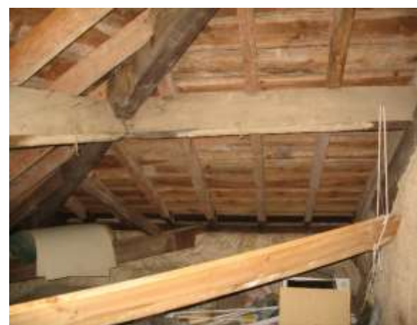
Figura 15 – Cobertura de madeira 2.
