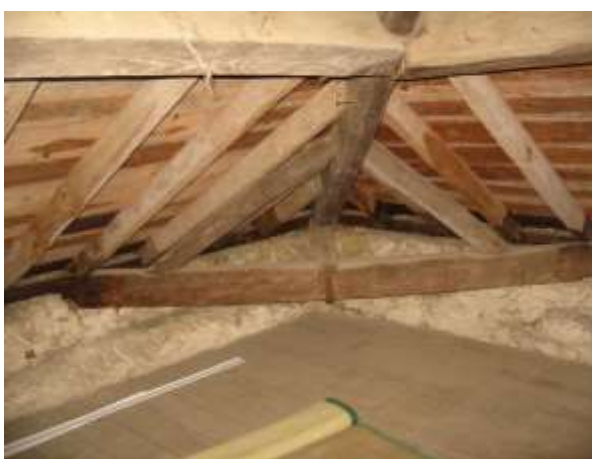
Figura 14 – Cobertura de madeira 1.
