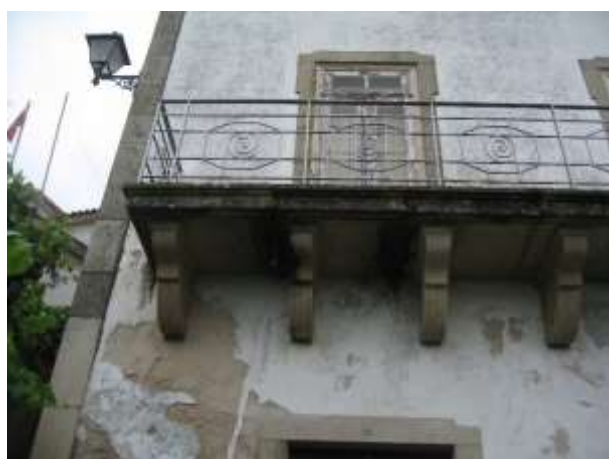
Figura 8 – Fachada do edifício + varanda.
