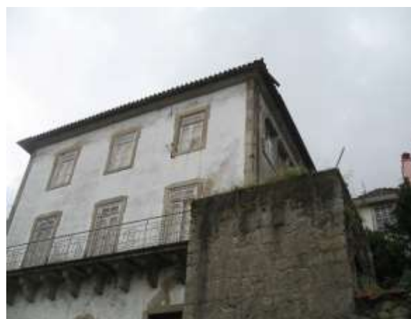
Figura 17 – Fachada - piso 1 e 2.
