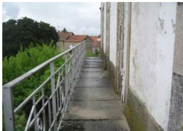
Figura 9 – Varanda do edifício.
