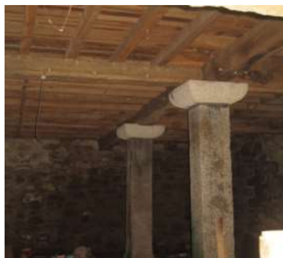
Figura 11 – Pilares e Vigas de suporte do teto do Rés-chão.
