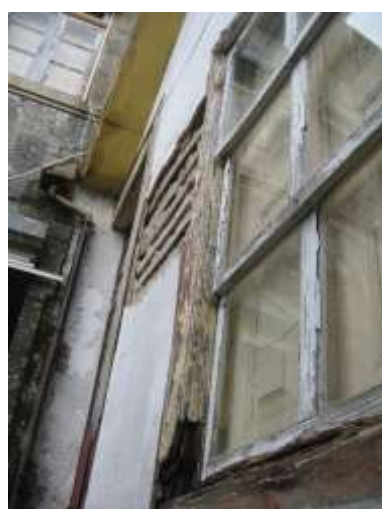
Figura 10 – Janela e parede do anexo.
