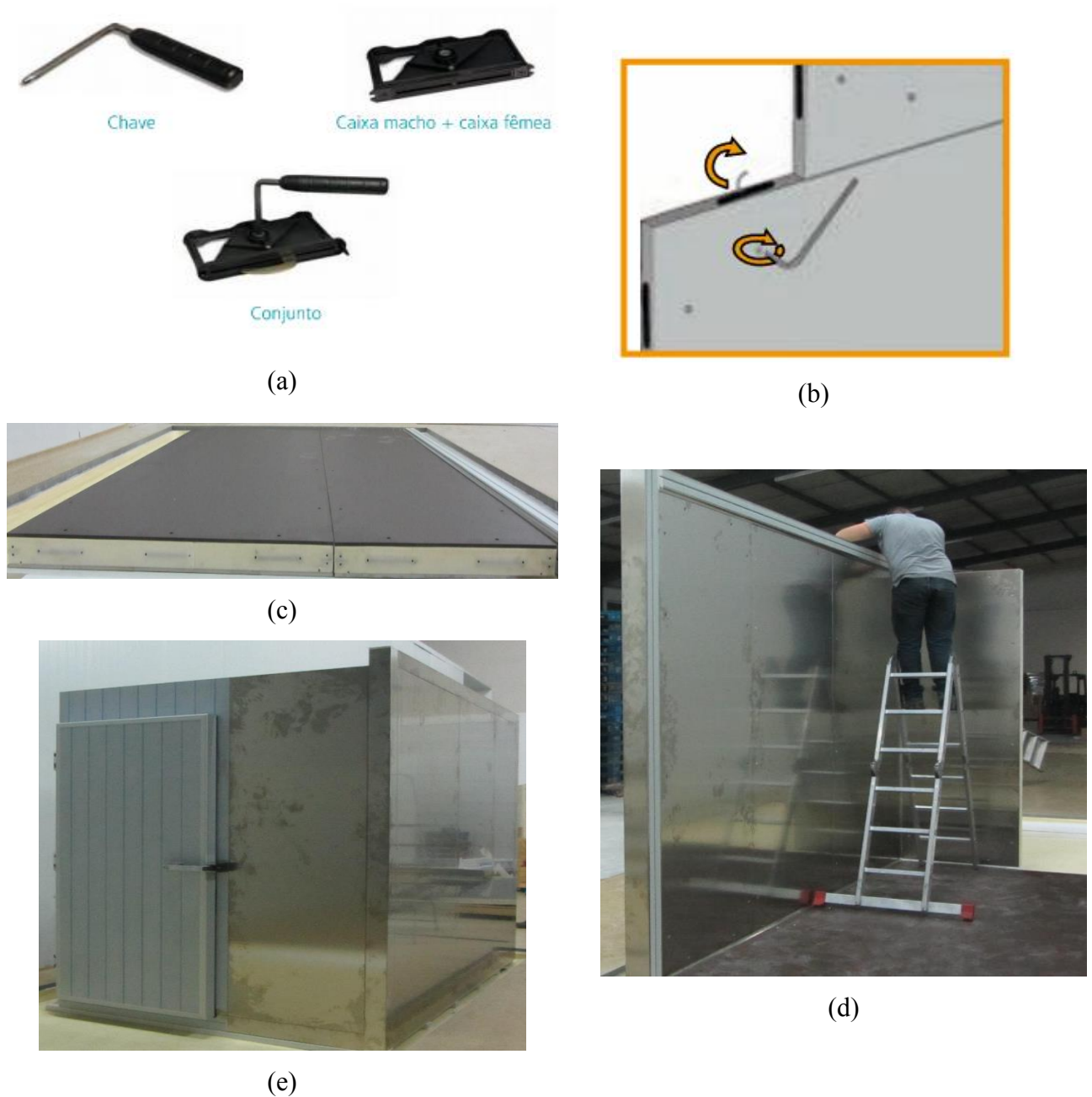
Figura 3.4 -Ligação dos painéis e montagem da câmara: (a) materiais utilizados na união entre painéis; (b) representação do método de ligação (Fonte [22]); (c) (d) (e) montagem da estrutura da câmara (Fonte: autor).
