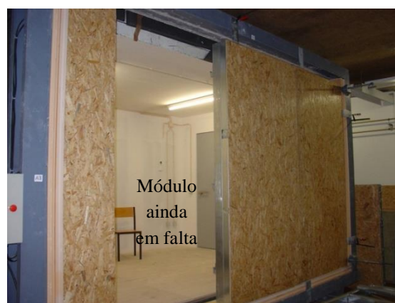
b) Vista exterior da parede LSF.
