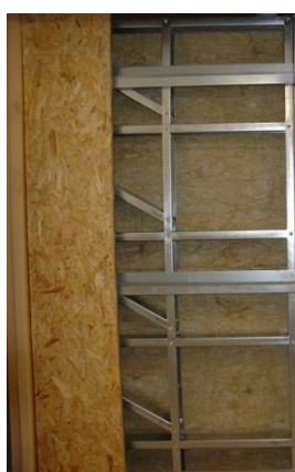
a) Vista interior da parede LSF.
