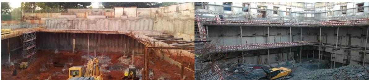
Figura 2.9: Exemplo de uma escavação contida em bandas de laje (Pinto & Tomásio, 2013)
