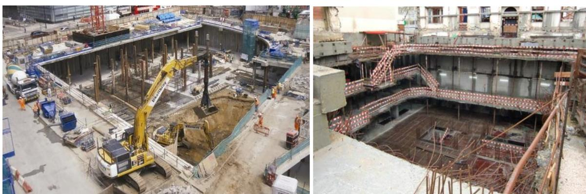
Figura 2.11: Exemplo de uma solução com método *top-down* (Pinto, 2016)
