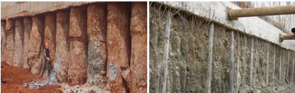
Figura 2.6: Exemplo de colunas de *Jet Grouting* (Pinto, 2016)
